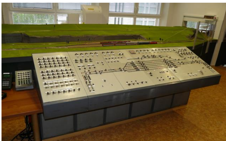
Obr. 3 Reléové zabezpečovací zařízení
