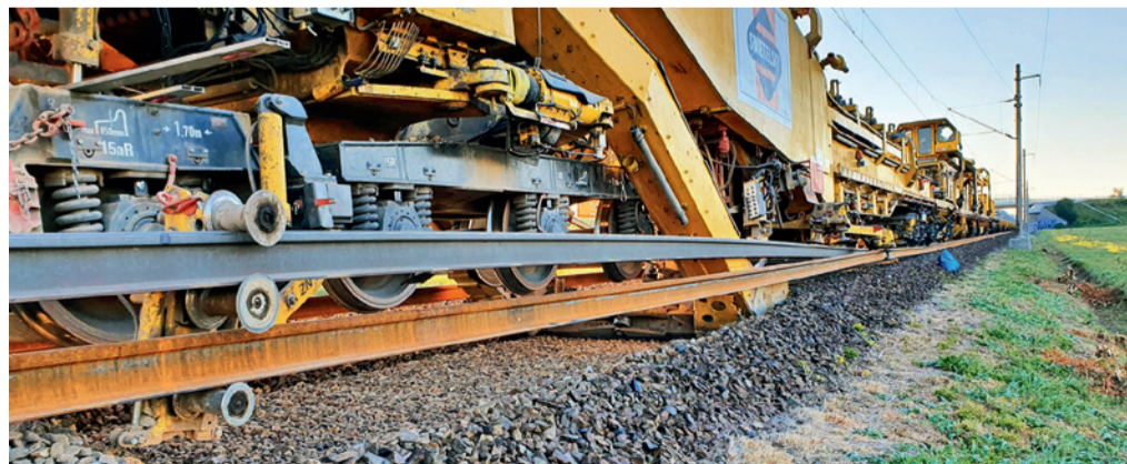
FOTO archiv Správy železnic
