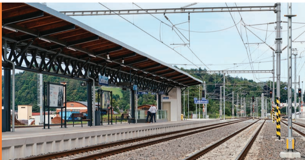
FOTO archiv Správy železnic (4x)
