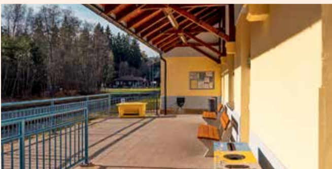
FOTO archiv Správy železnic (2x)
