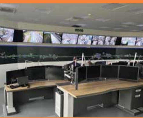
FOTO archiv Správy železnic
