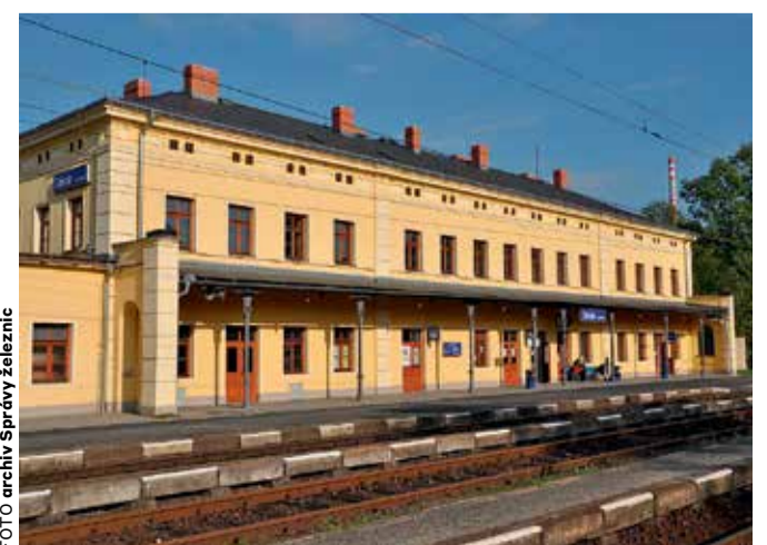
FOTO archiv Správy železnic
