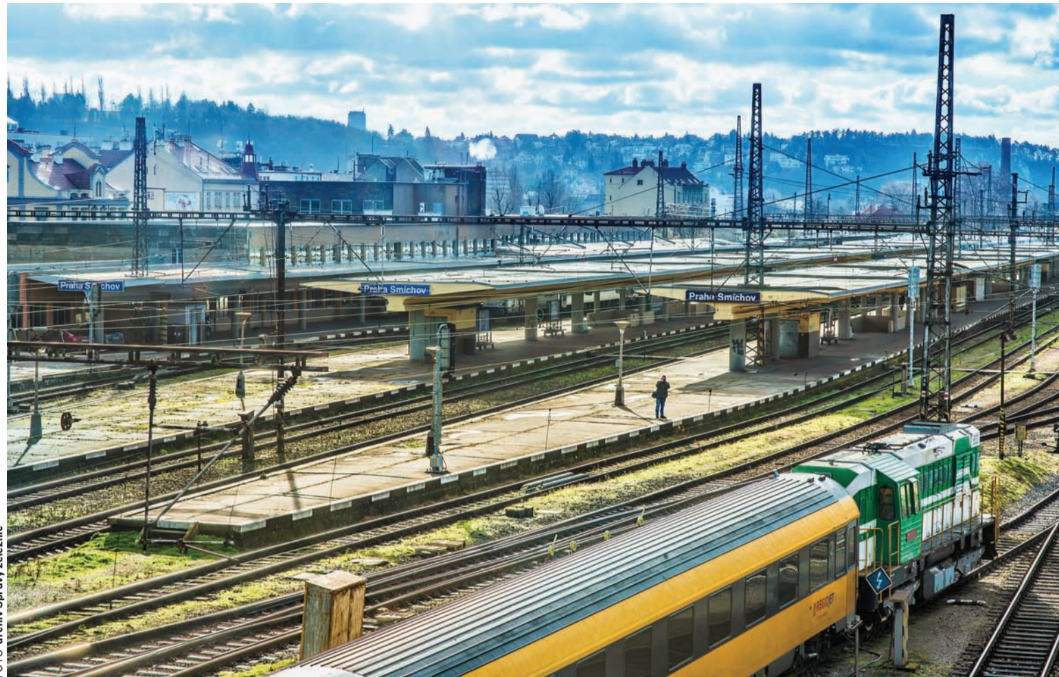
FOTO archiv Správy železnic
