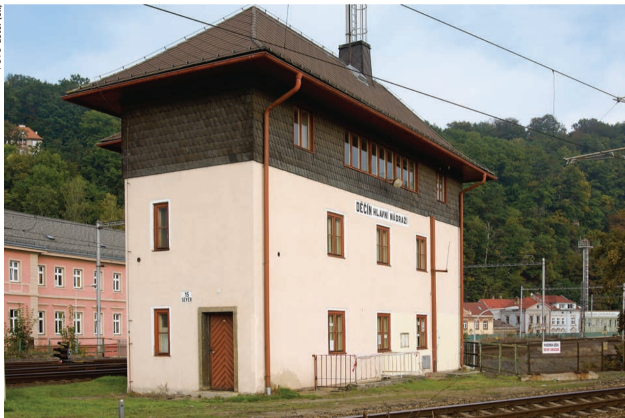
Muzeum sídlí v objektu bývalého stavědla, odkud se řídil provoz na severním zhlaví stanice.
