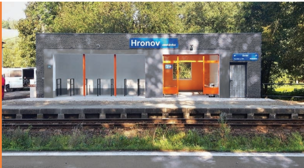
FOTO archiv Správy železnic (5x)
