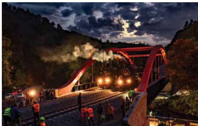
Zdeněk Adler: Zatěžovací zkouška
