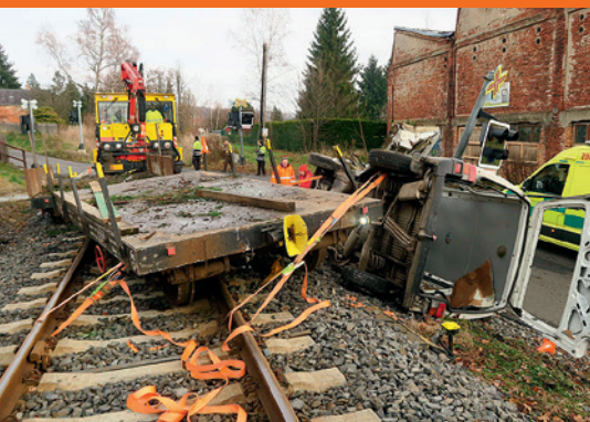
FOTO archiv Správy železnic (2x)
