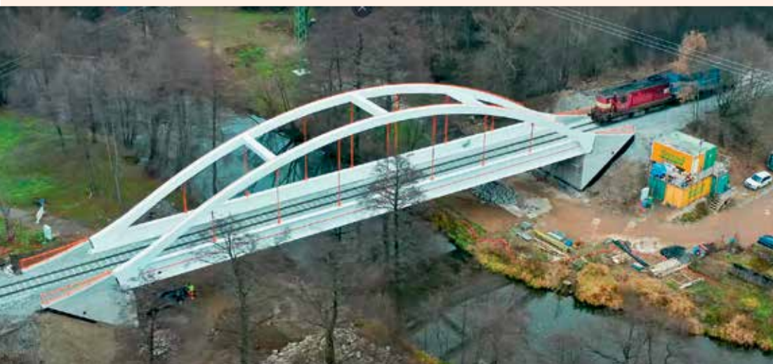
FOTO: archiv Správy železnic (4x)
