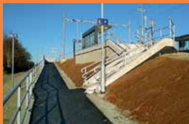
FOTO archiv Správy železnic
