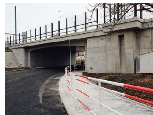
FOTO archiv Správy železnic
