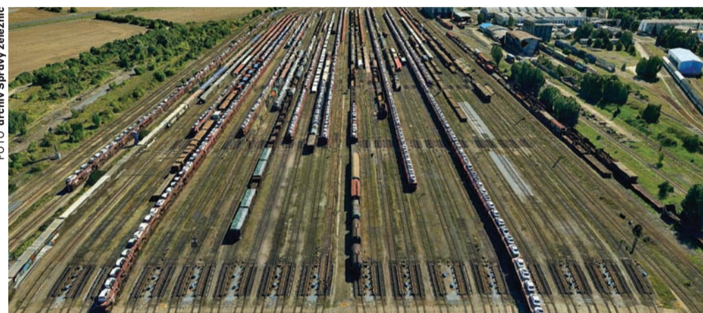
FOTO archiv Správy železnic
