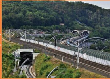
FOTO archiv Správy železnic
