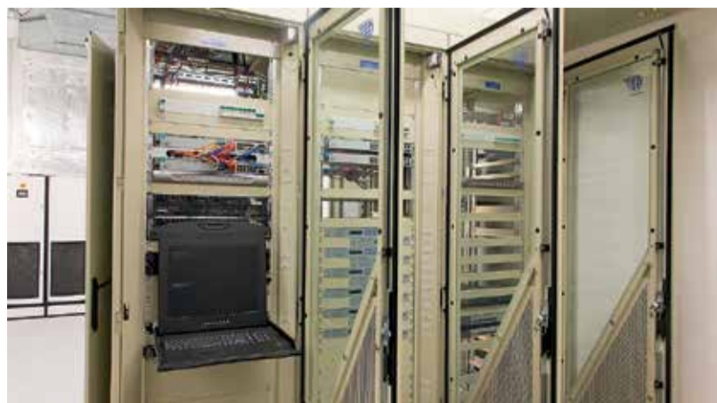
FOTO archiv Správy železnic
