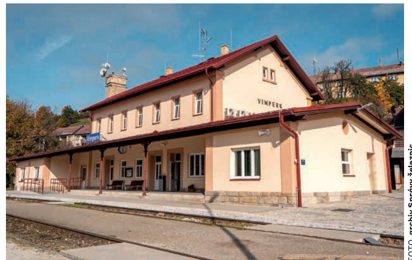
FOTO archiv Správy železnic
