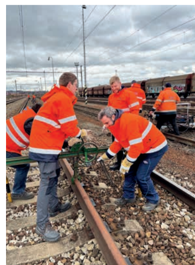
FOTO archiv Správy železnic
