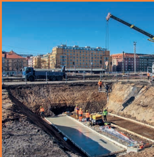
FOTO archiv Správy železnic
