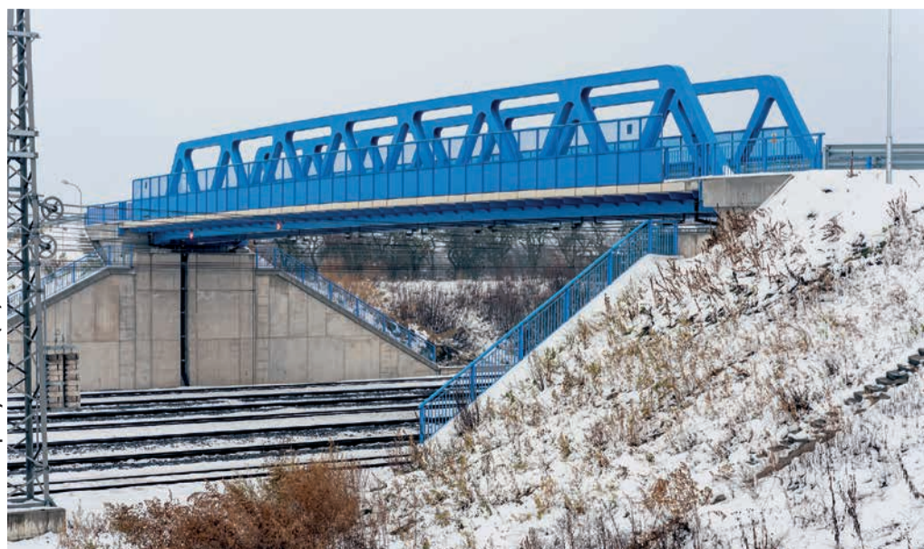
FOTO archiv Správy železnic (2x)
