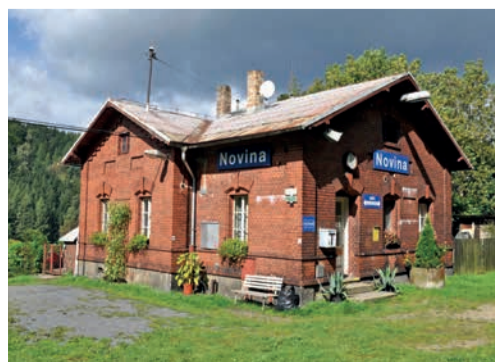
Pro celou trať jsou typické cihlové nádražní budovy, tato je konkrétně na zastávce Novina
