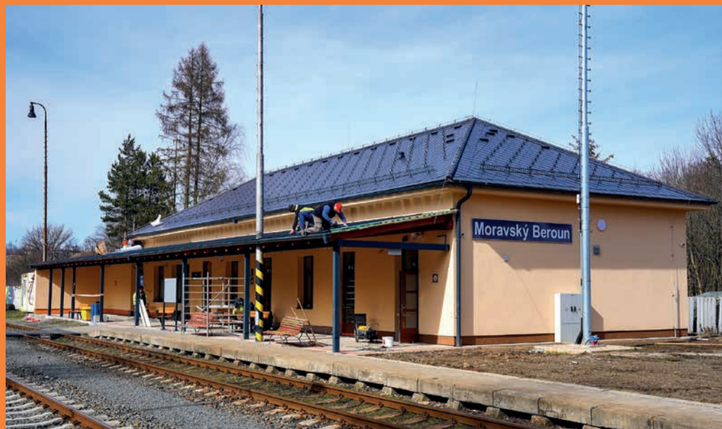
FOTO archiv Správy železnic (2x)
