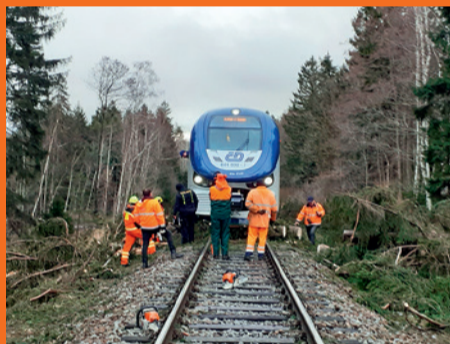
FOTO archiv Správy železnic (2x)
