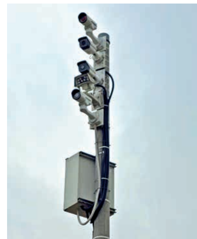
FOTO archiv Správy železnic (2x)
