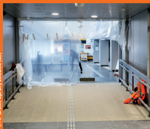
FOTO archiv Správy železnic (3x)
