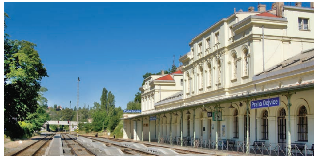
FOTO archiv Správy železnic
