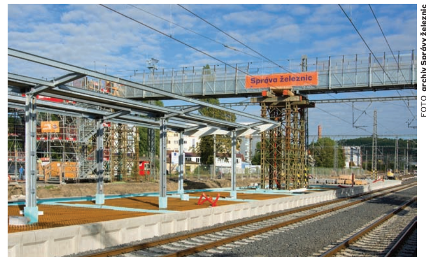
FOTO archiv Správy železnic
