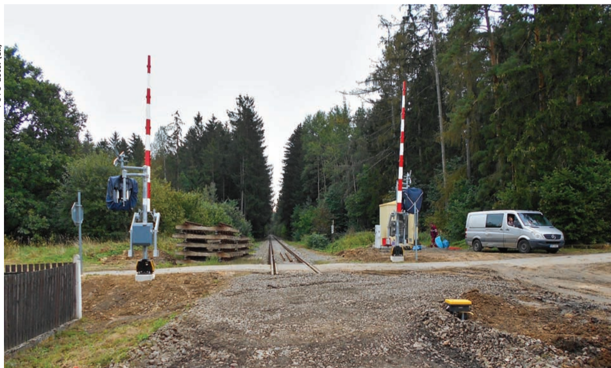
Rekonstrukce přejezdu v km 23,011 odstraní výrazný propad traťové rychlosti.
