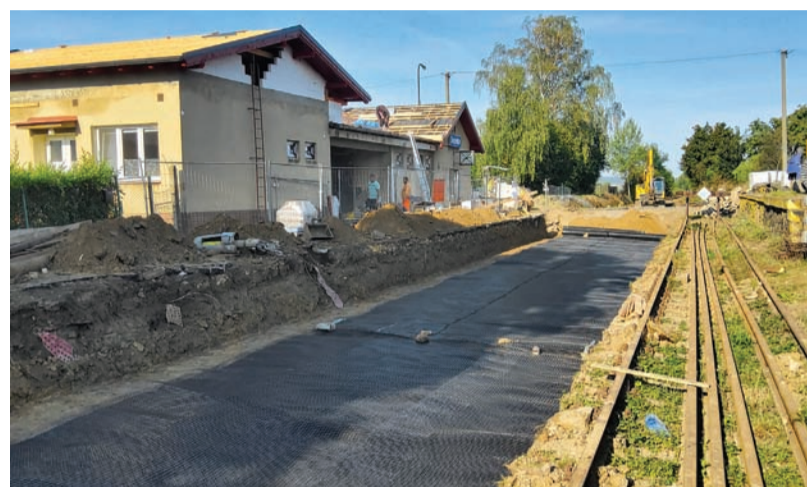
V rámci rekonstrukce se vyměnil na zastávce i železniční svršek.
