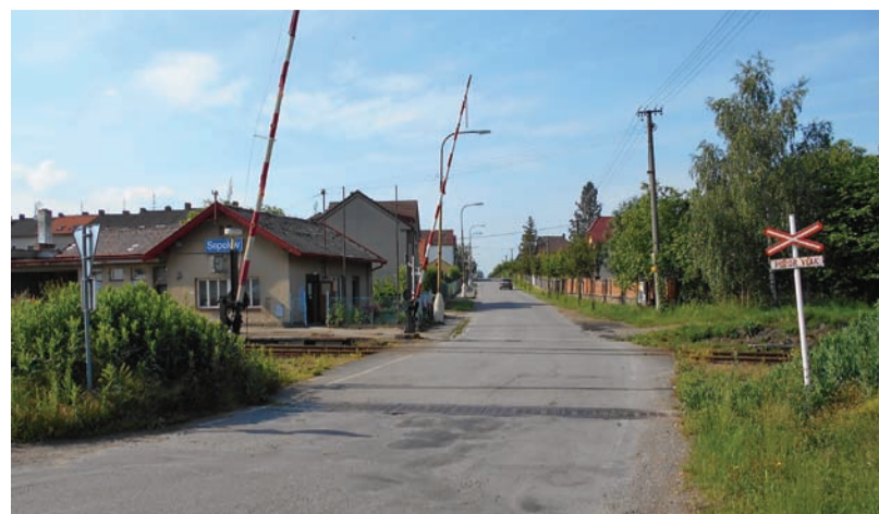
Takto vypadal přejezd v Sepekově před zahájením rekonstrukce.
