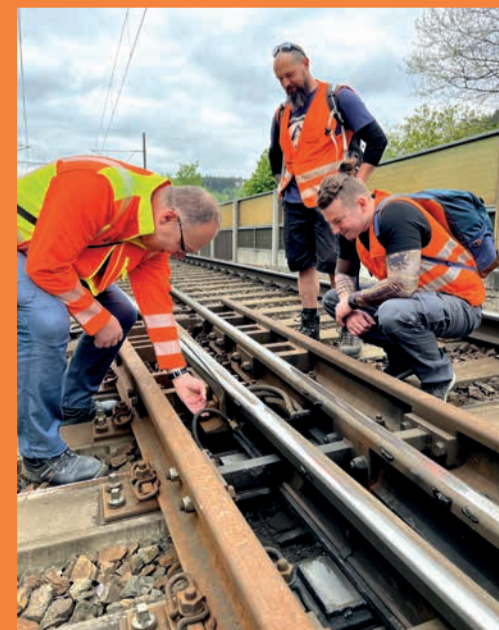
FOTO archiv Správy železnic (5x)
