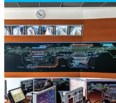
FOTO archiv Správy železnic (2x)
