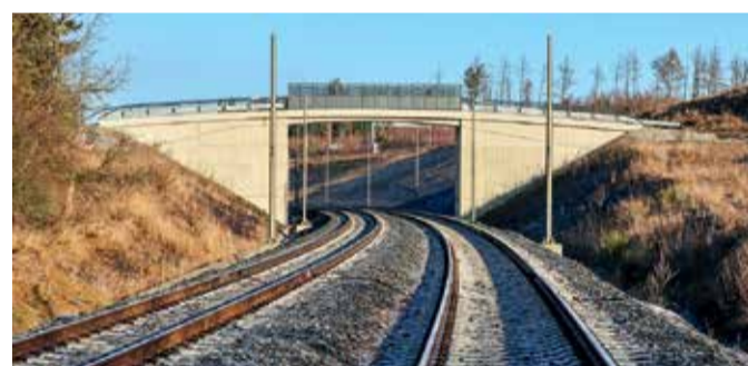
Nové přemostění železničního koridoru u Mezna
