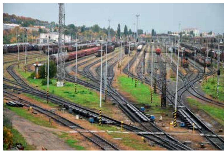
FOTO archiv Správy železnic
