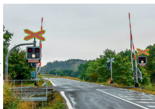
FOTO archiv Správy železnic (2x)
