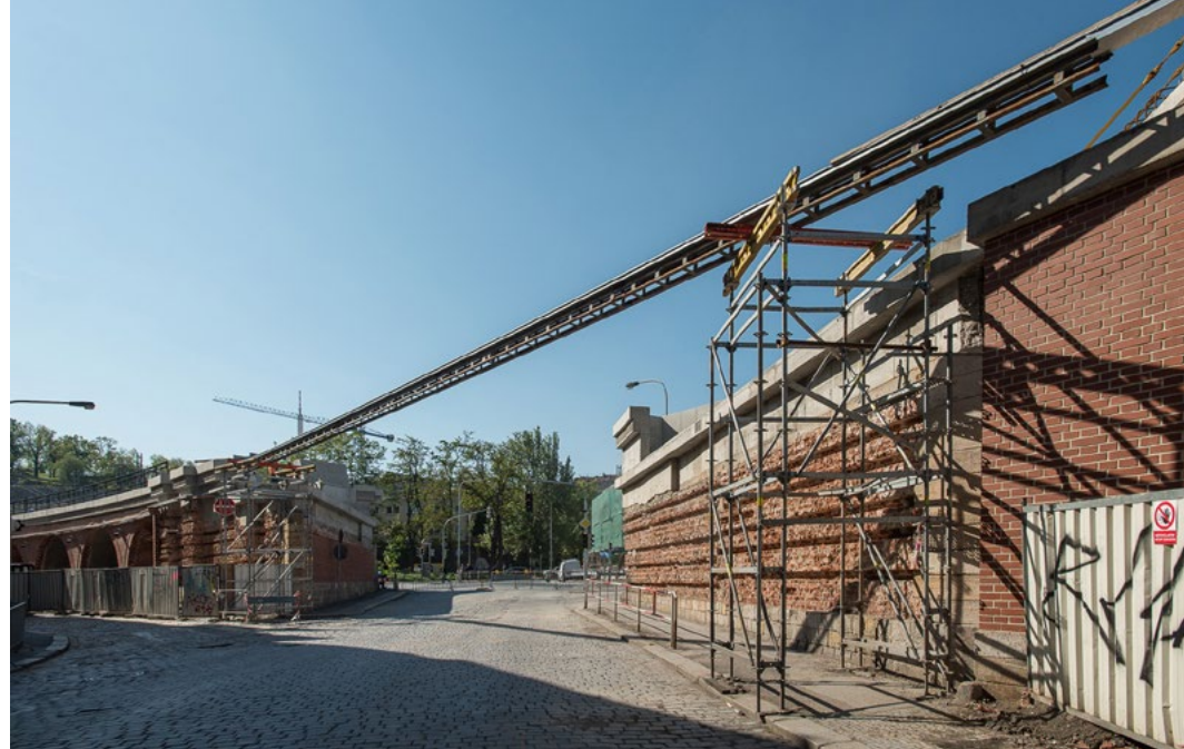
Viadukt po snesení nevyhovující nosné konstrukce mostu přes ulici Prvního pluku
