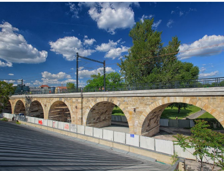
Pískovcový klenbový most na ostrově Štvanice
