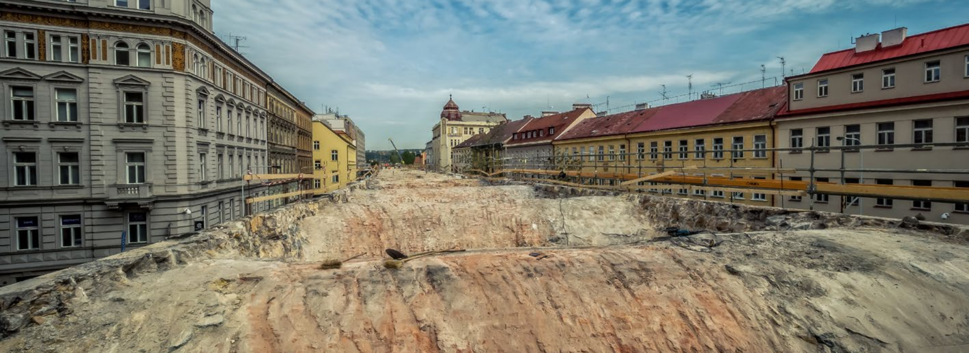
Odhalené ruby kleneb v průběhu rekonstrukce
