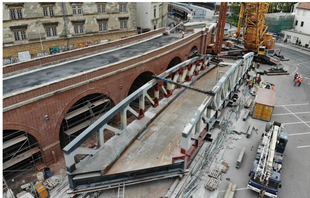
Svařování nové nosné ocelové konstrukce mostu přes ulici Prvního pluku
