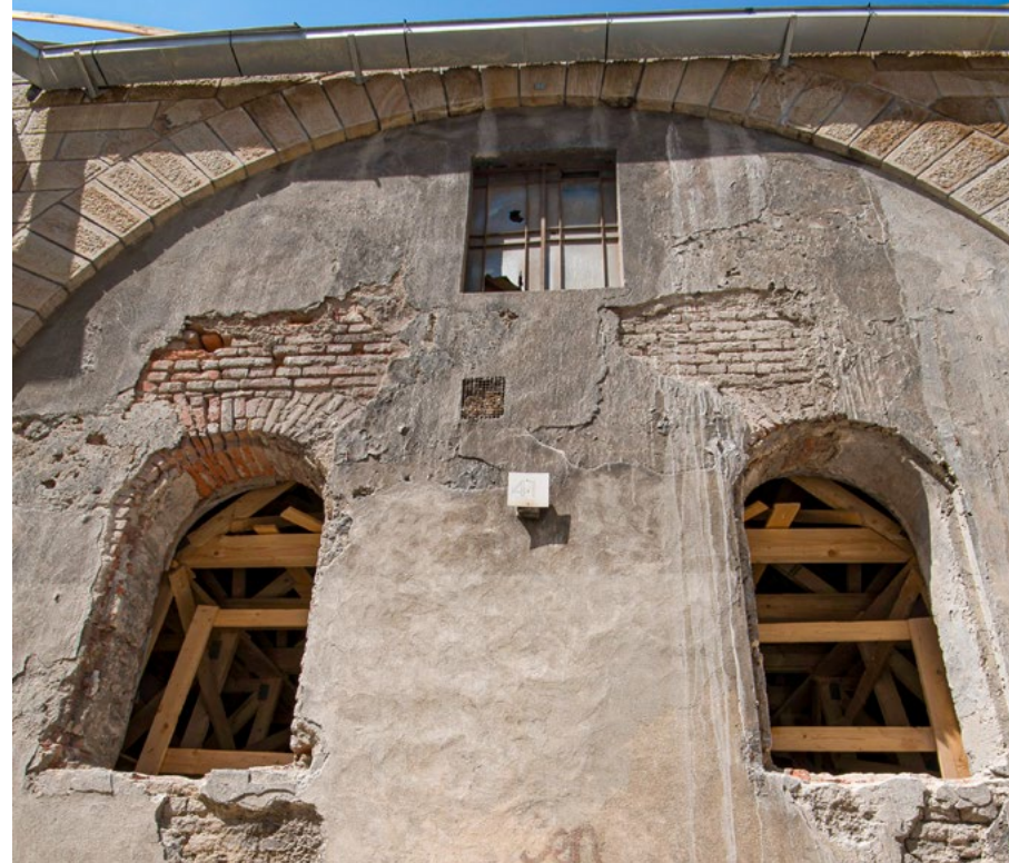
Památkově chráněný objekt bývalé celnice během rekonstrukce
