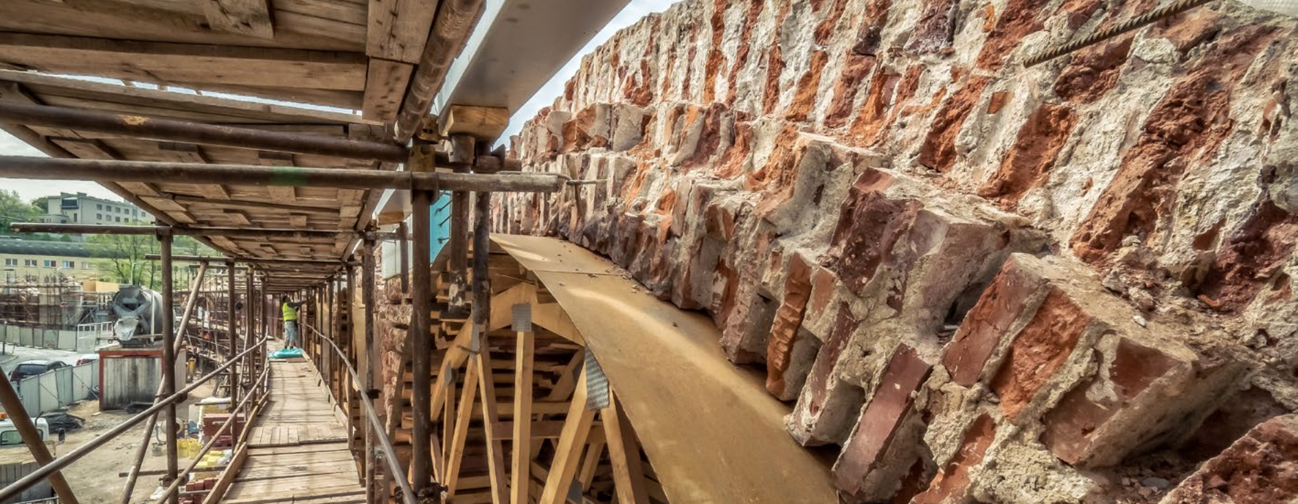
Přezdívání líčového zdiva cihelných kleneb na hrabovské větvi
