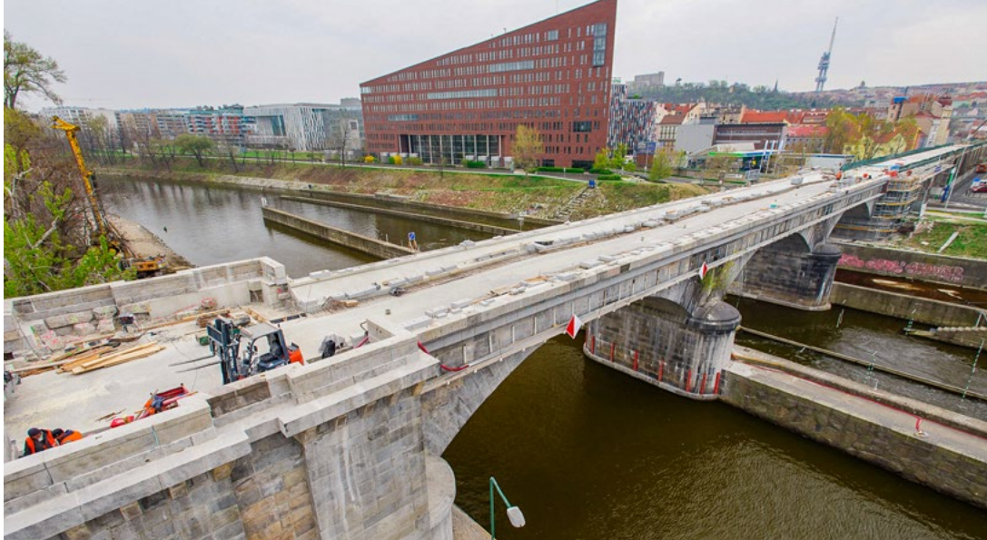
Most nad plavební komorou v průběhu rekonstrukce Žulový most mezi ostrovem Štvanice a Bubenským nábřežím
