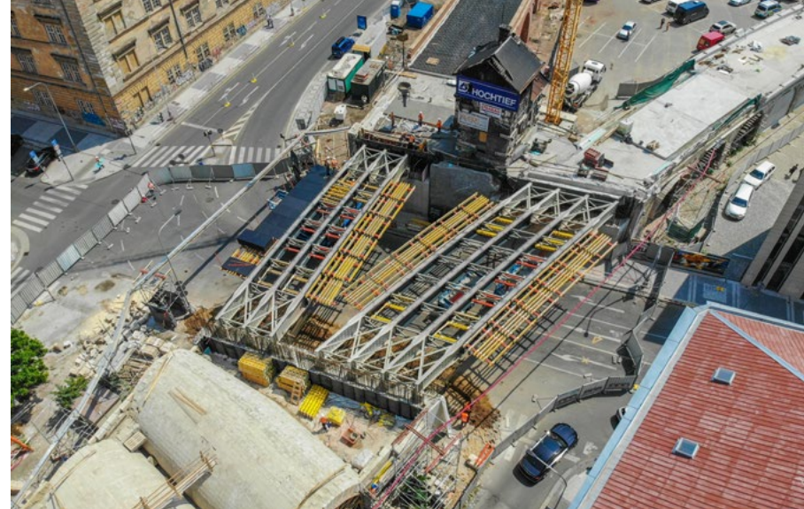
Příprava na betonáž
