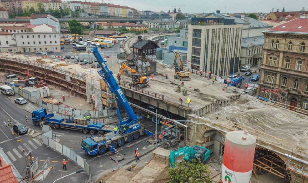
Demontáž starého mostu přes Křižíkovu ulici
