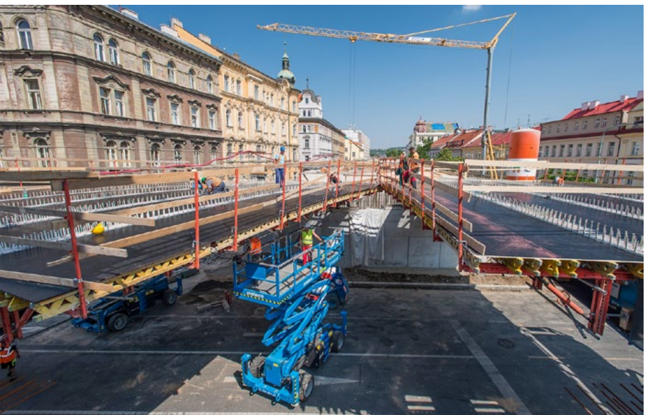
Konstrukce nového mostu přes Křížkovu ulici
