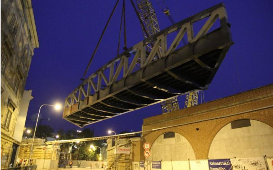
Osazování nové nosné konstrukce mostu přes ulici Prvního pluku
