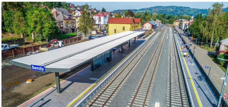
Příklad aplikace typových řešení využitých při rekonstrukci stanice Semily (zastřešení nástupiště, povrchy nástupiště, zábradlí, sdržené stožáry)
