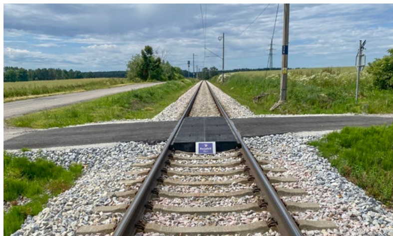
...a po opravě
