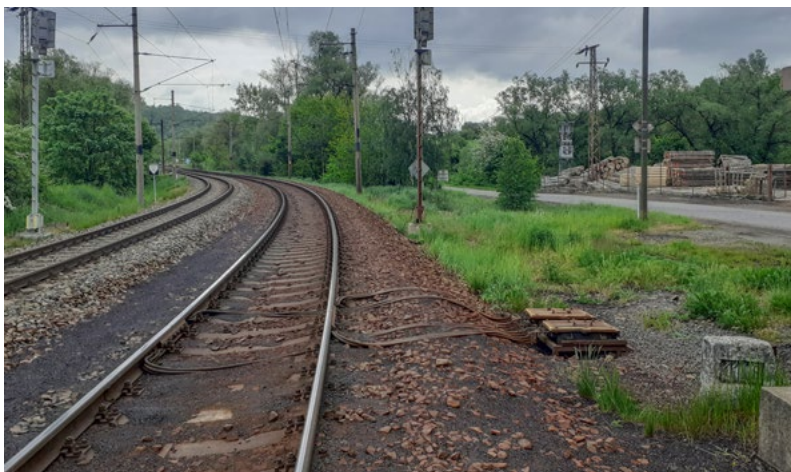
Stav před opravou...
