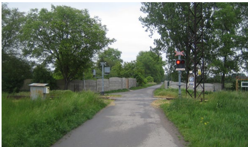
Stav před opravou...
