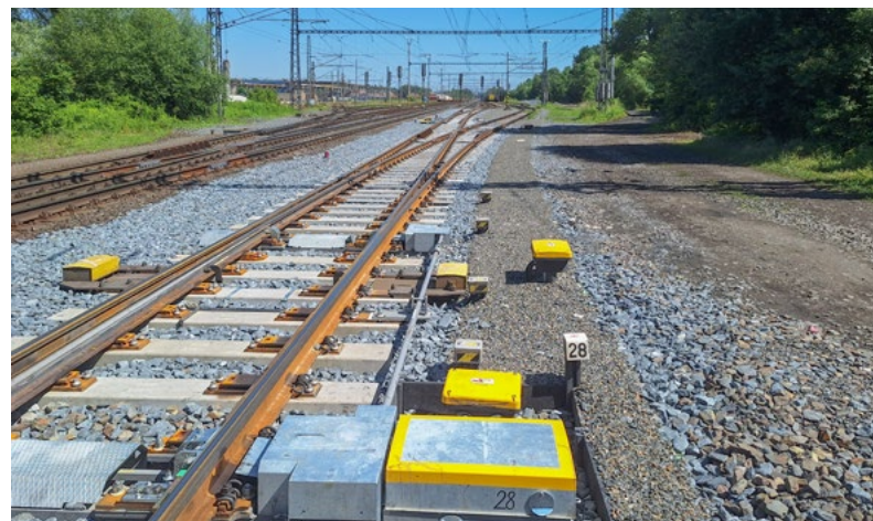
...a po opravě
