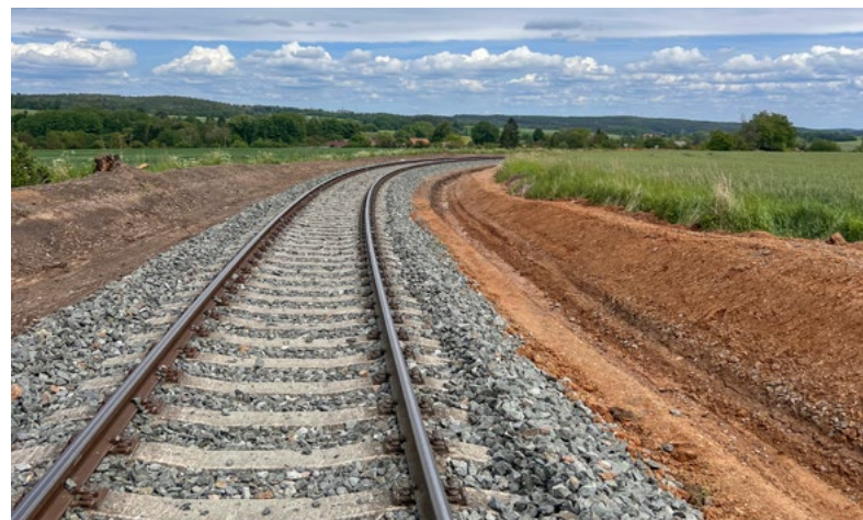
...a po opravě
