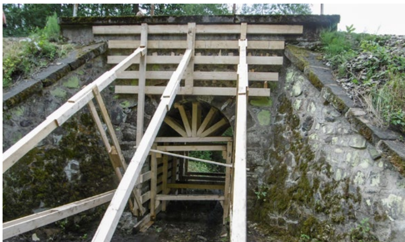
Stav před opravou...
