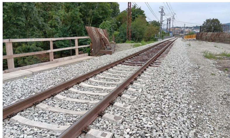
...a po opravě
