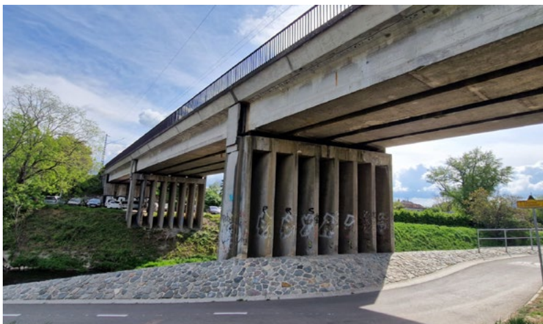
Stav před opravou...
