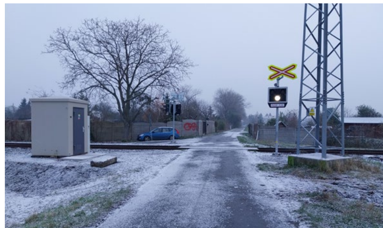
...a po opravě
