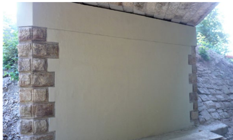
...a po opravě
