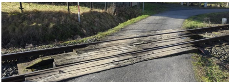
Stav před opravou...
