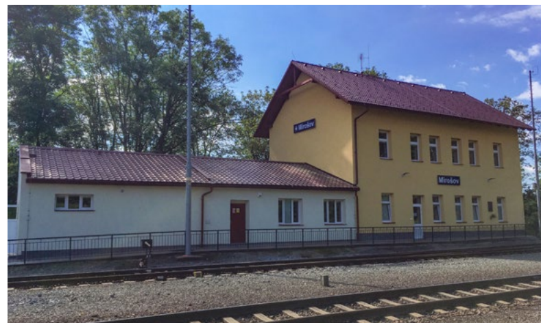
...a po opravě
