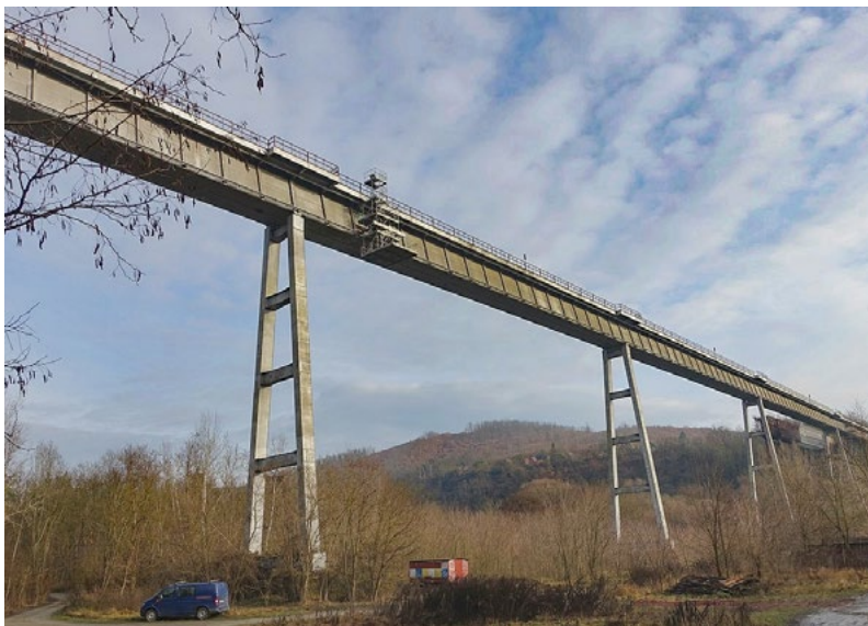
Jeden z mostů posuzovaných v rámci projektu Diagnostika a přepočty strategických přemostění – most v km 130,187 na trati Hrušovany nad Jevišovkou – Brno-Horní Heršpice – Ivančický viadukt
