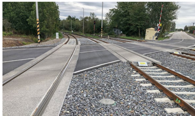
...a po opravě
