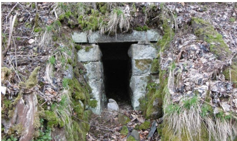
Stav před opravou...
