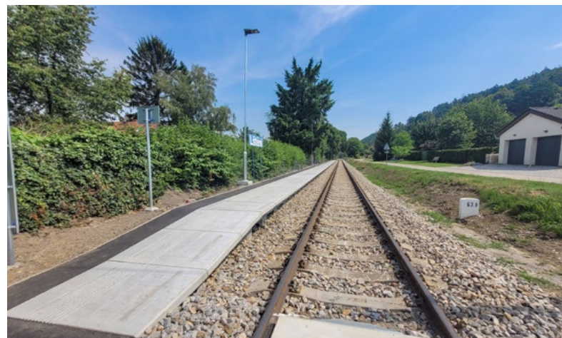
...a po opravě
