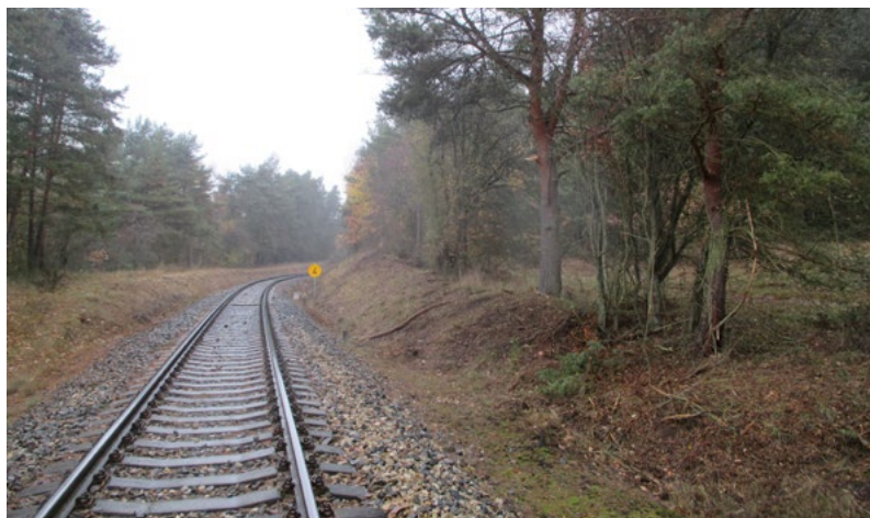
Stav před opravou...
