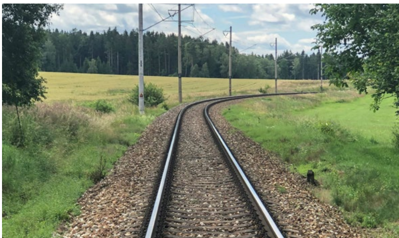
Stav před opravou...
