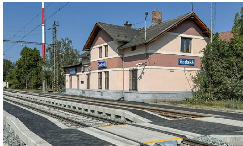
...a po opravě
