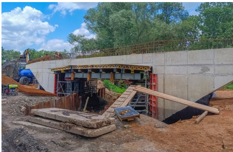
Prostá rekonstrukce trati v úseku Louny – Radonice nad Ohří
