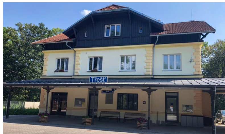
...a po opravě
