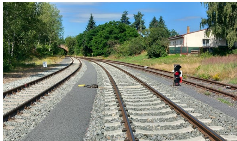
...a po opravě
