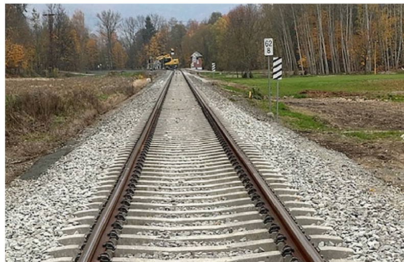
...a po opravě
