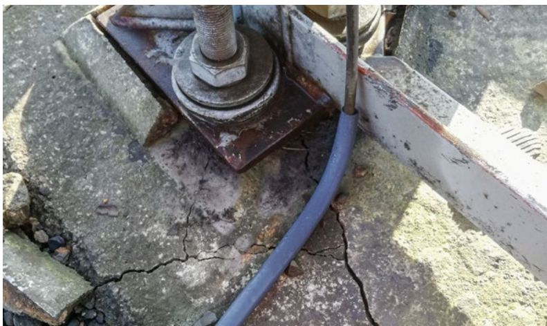
Stav před opravou...
