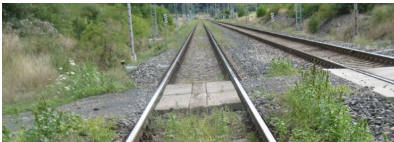
Stav před opravou...
