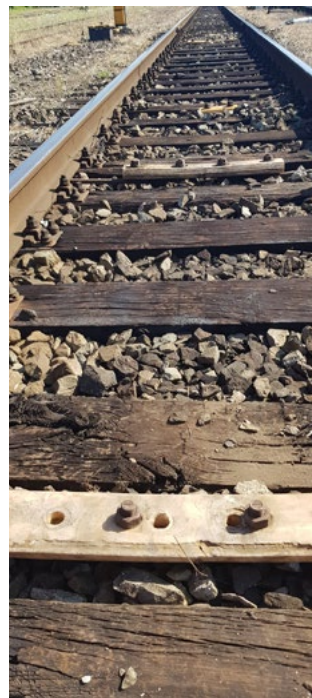
Stav před opravou...
