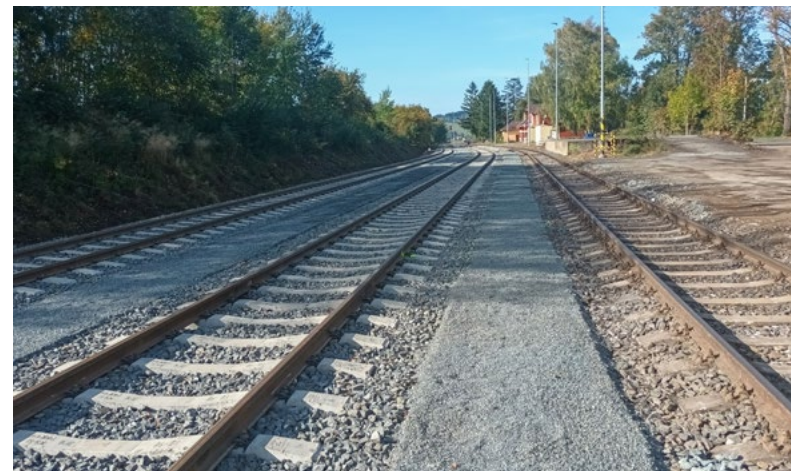
...a po opravě
