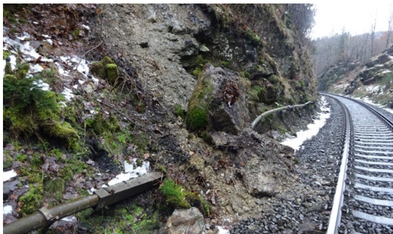
Stav před opravou...
