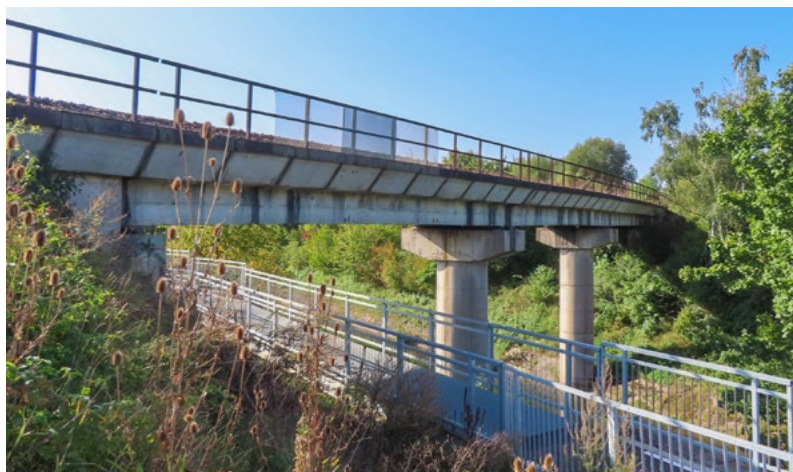
Stav před opravou...
