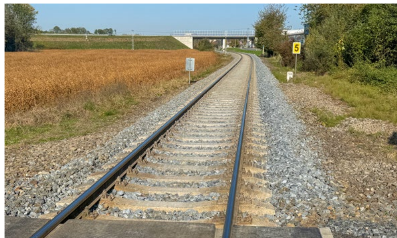
...a po opravě
