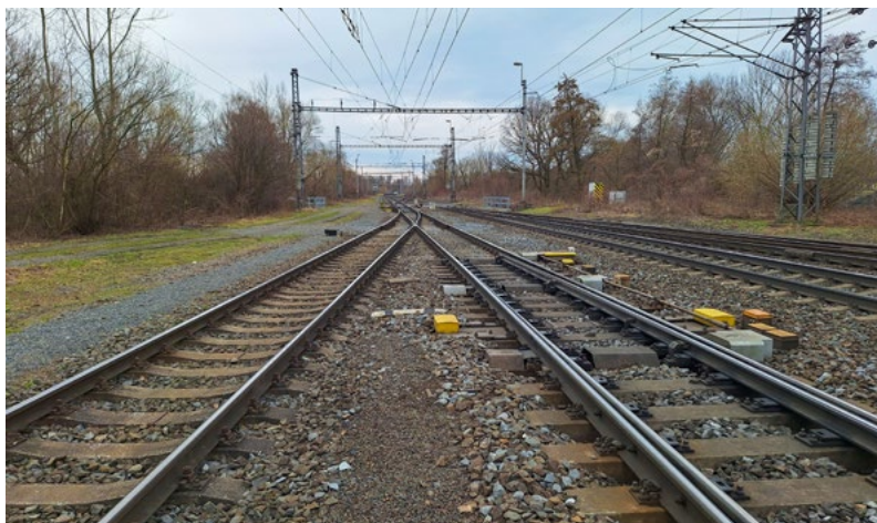
Stav před opravou...
