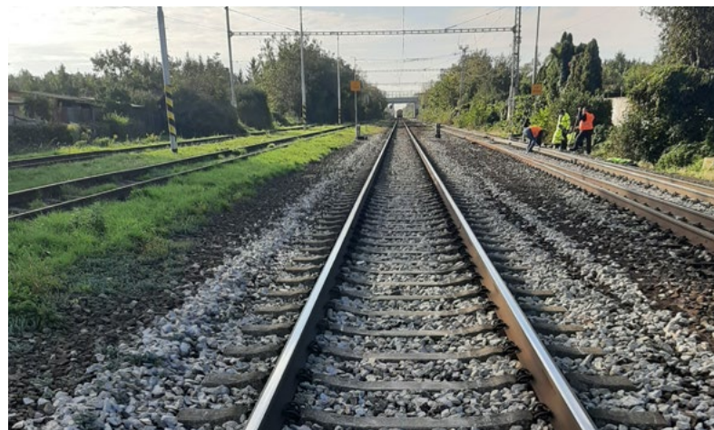
...a po obnově
