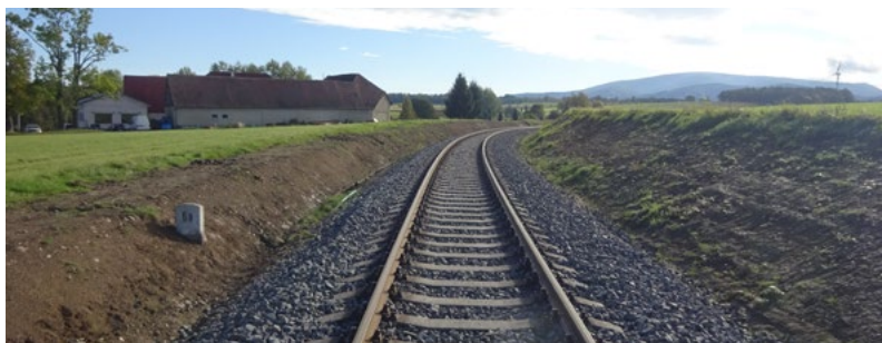
...a po opravě
