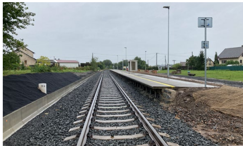
...a po opravě
