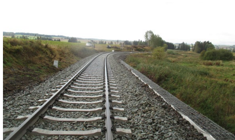
...a po opravě
