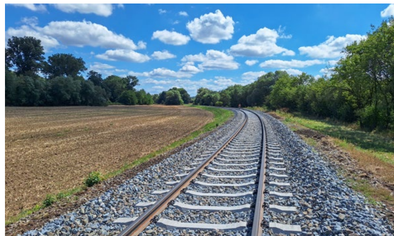
...a po opravě
