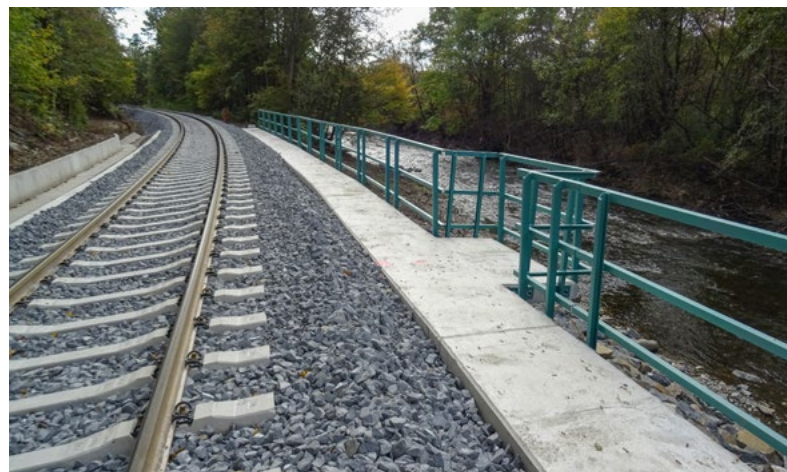
...a po opravě
