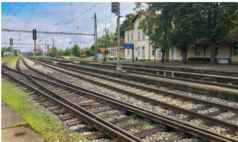
Stav před opravou...
