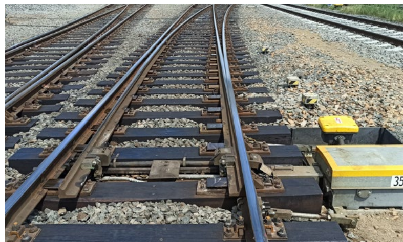
...a po opravě
