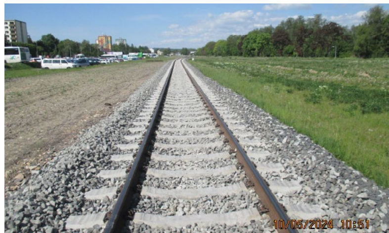
...a po opravě
