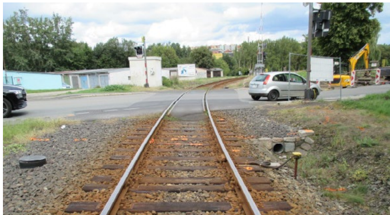
Stav před opravou...
