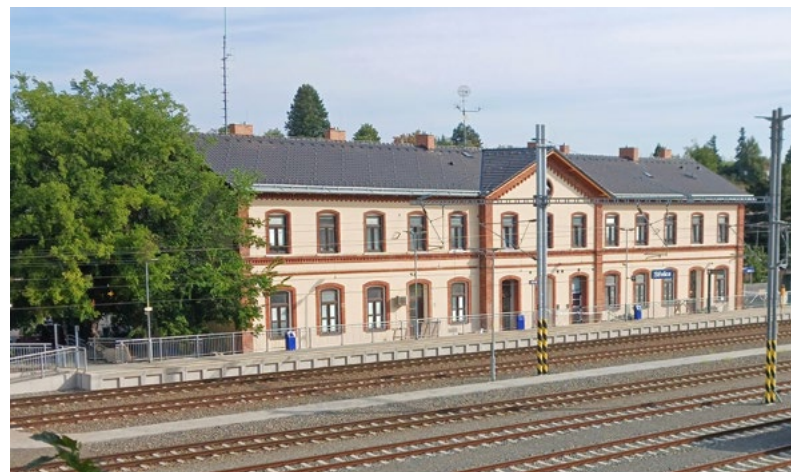
...a po opravě
