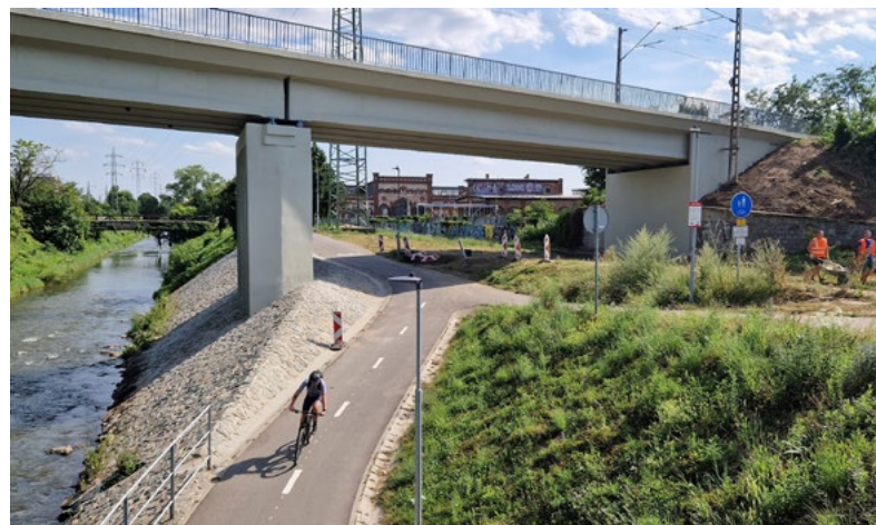
...a po opravě
