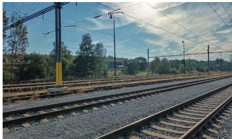
...a po opravě
