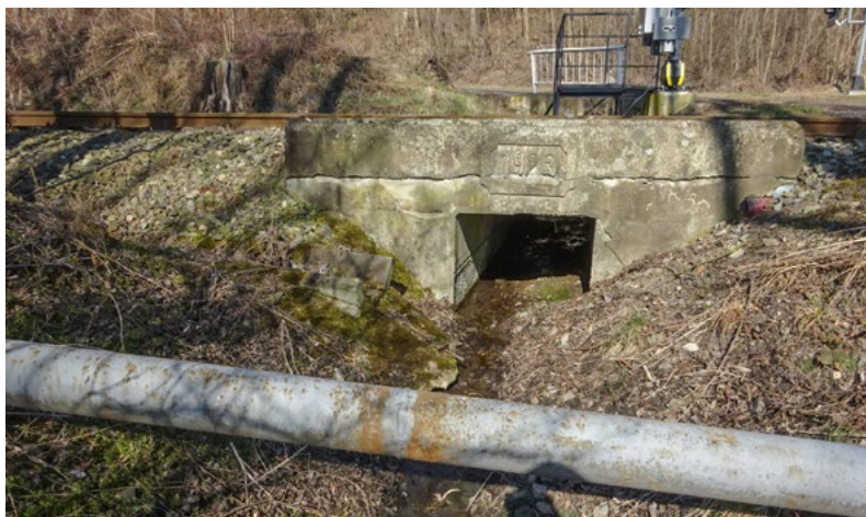
Stav před opravou...
