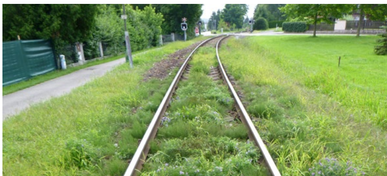
Stav před opravou...
