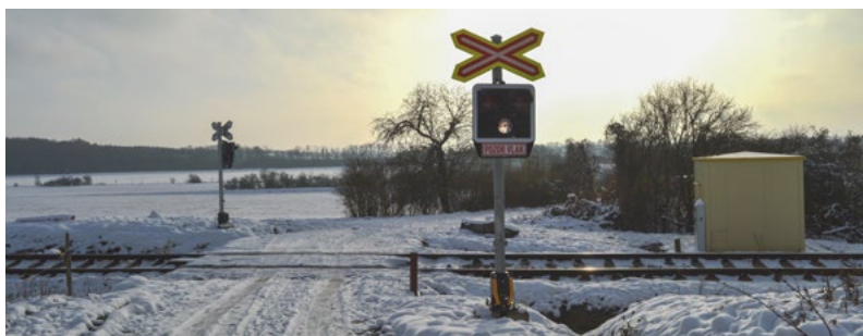
...a po opravě
