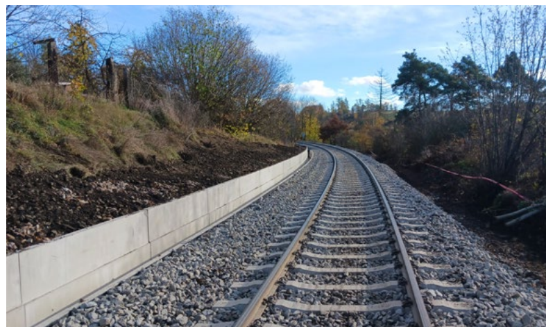
...a po opravě
