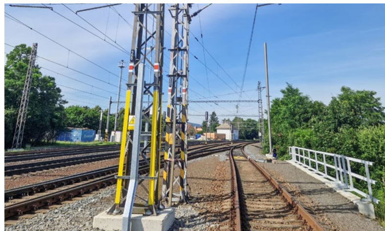
...a po opravě
