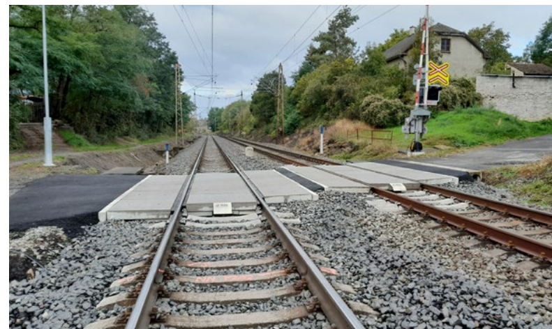
...a po opravě
