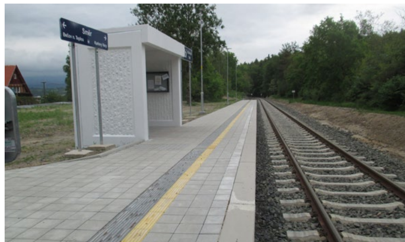
...a po opravě
