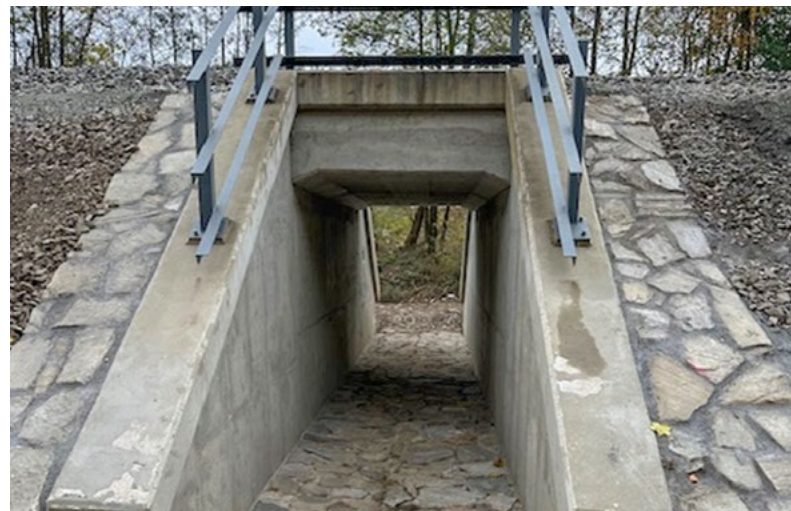
...a po opravě
