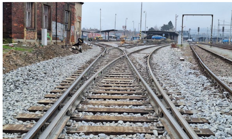
...a po opravě
