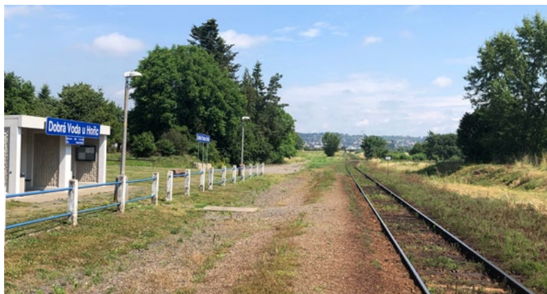
Stav před opravou...
