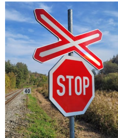
Obnovené dopravní značení
