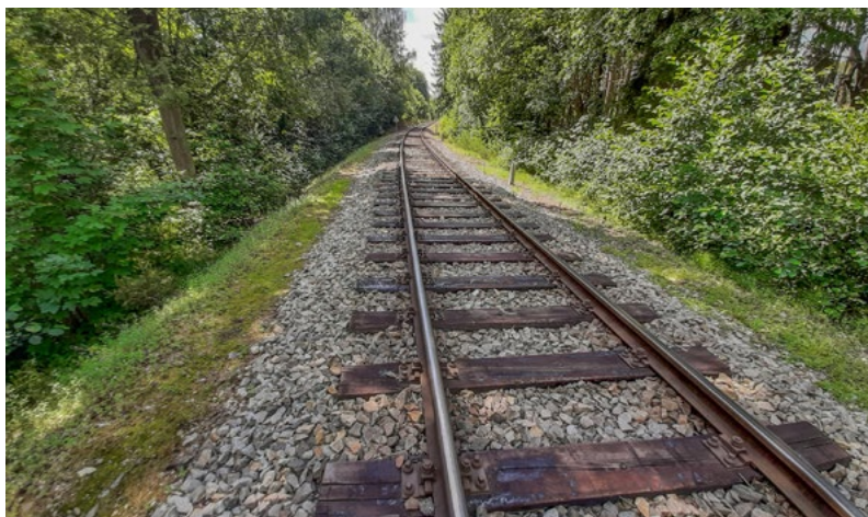
Stav před opravou...
