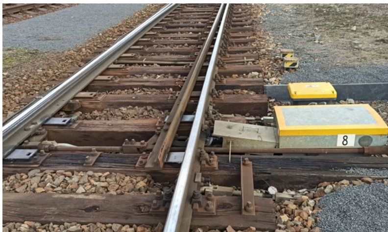
Stav před opravou...
