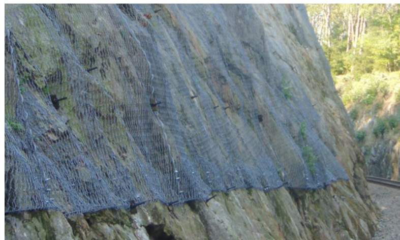
...a po opravě
