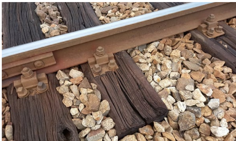
Stav před opravou...
