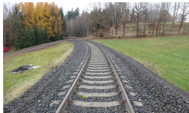
...a po opravě
