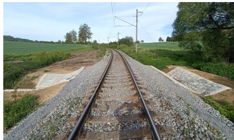
...a po opravě
