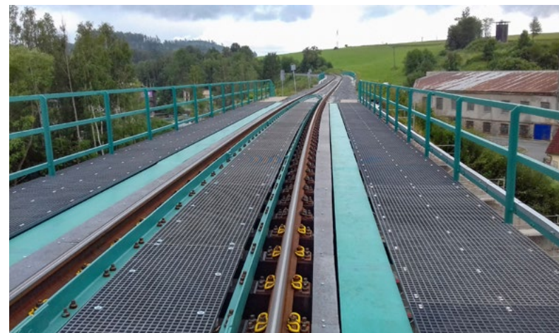
...a po opravě
