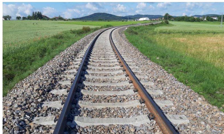
...a po opravě
