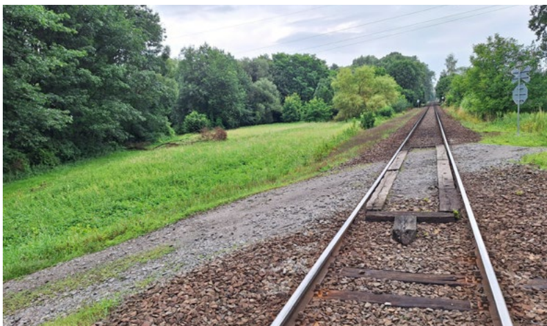
Stav před opravou...
