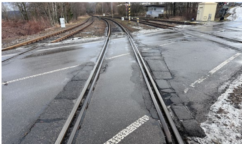
Stav před opravou...
