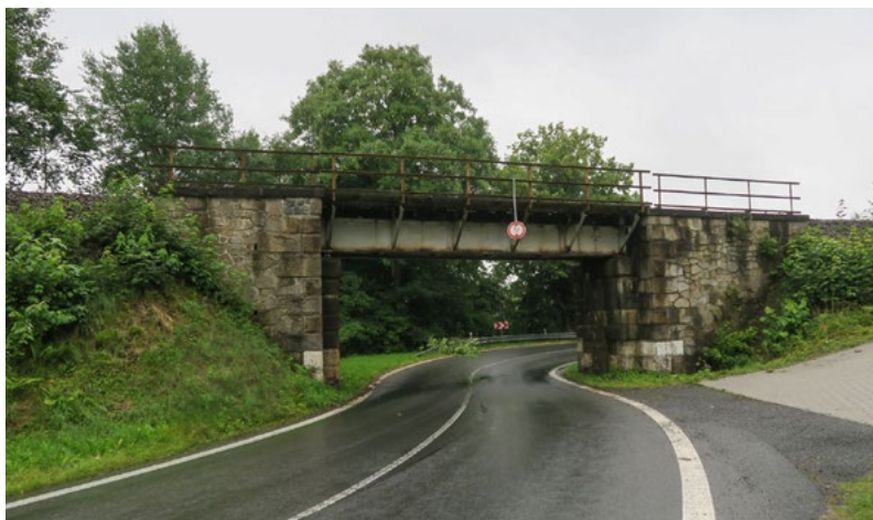
Stav před opravou...
