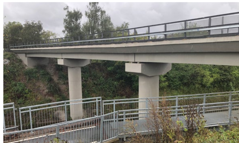
...a po opravě
