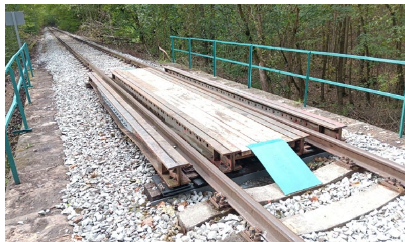
...a po opravě
