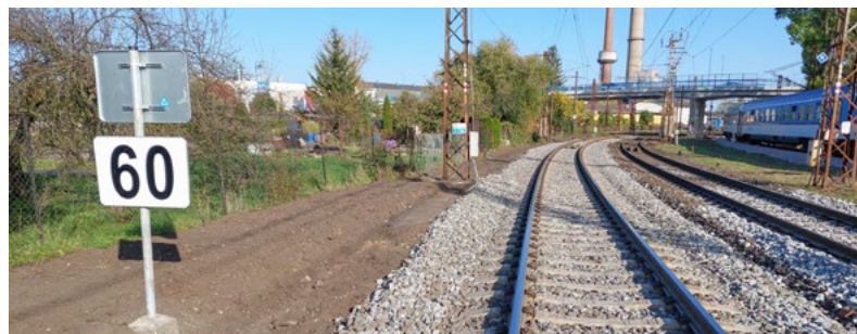
...a po opravě
