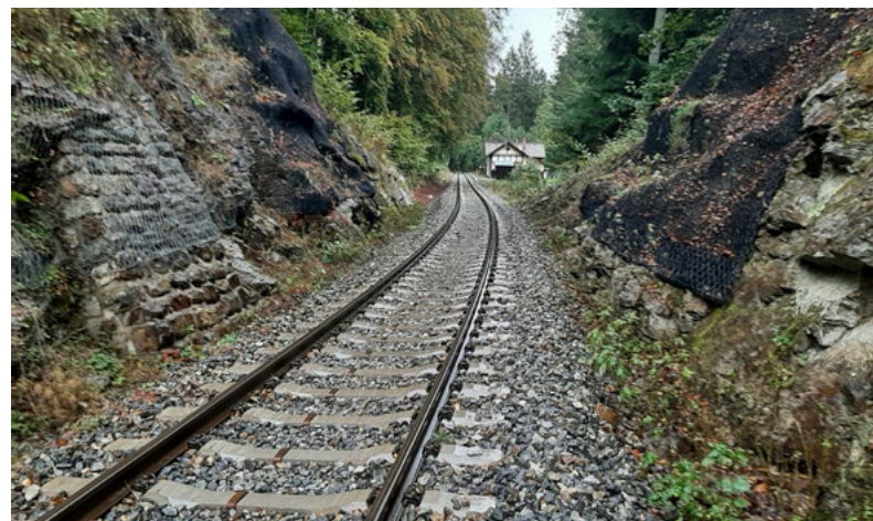
...a po opravě
