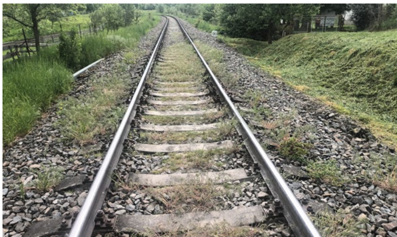
Stav před opravou...
