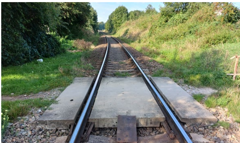
Stav před opravou...
