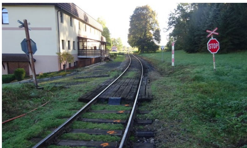
Stav před opravou...
