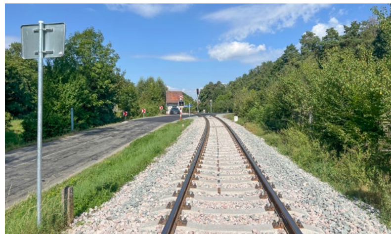
...a po opravě
