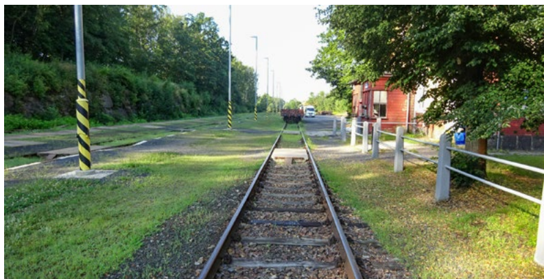
Stav před zahájením prosté rekonstrukce...
