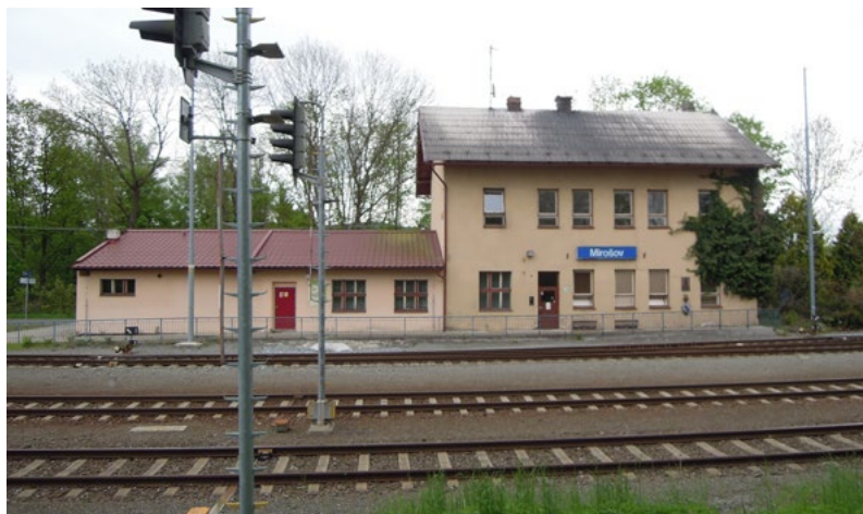
Stav před opravou...
