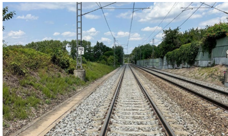
...a po obnově
