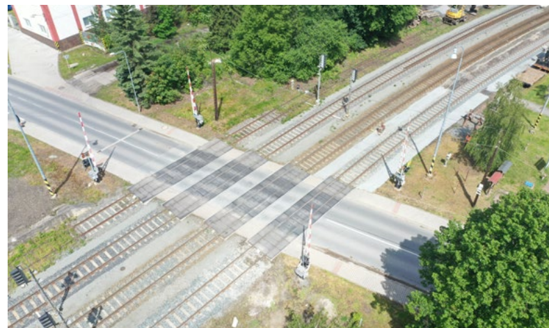
...a po opravě
