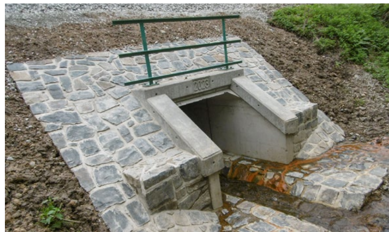
...a po opravě
