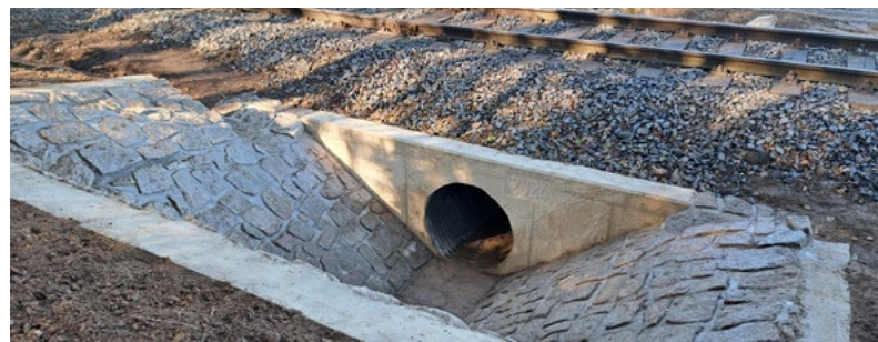
...a po opravě
