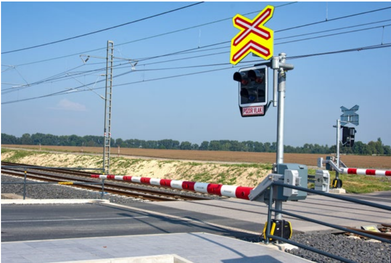
Příklad železničního přejezdu po rekonstrukci
