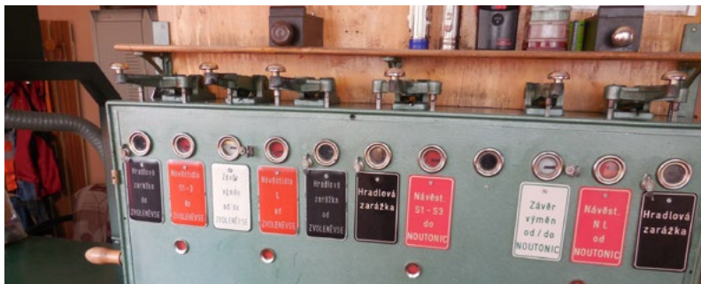
Stav před opravou...
