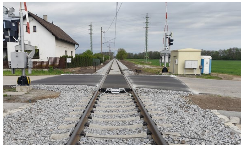
...a po opravě
