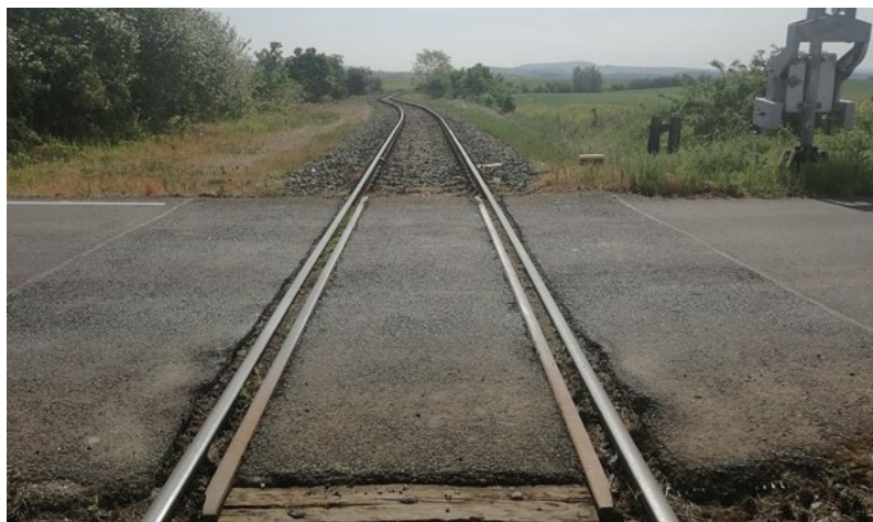
Stav před opravou...
