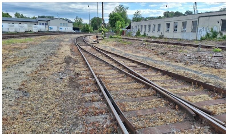
Stav před opravou...
