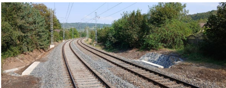
...a po opravě
