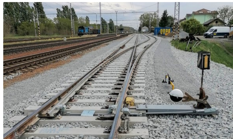
...a po opravě
