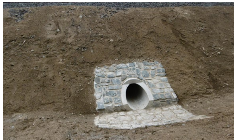
...a po opravě
