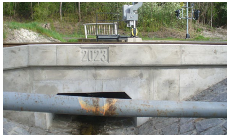
...a po opravě
