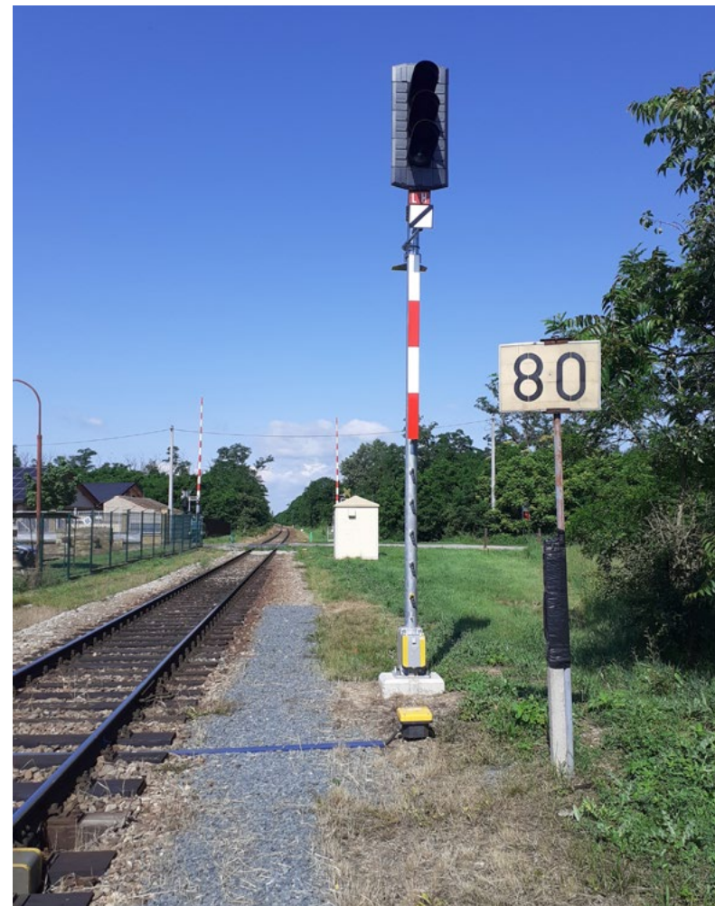
...a po opravě
