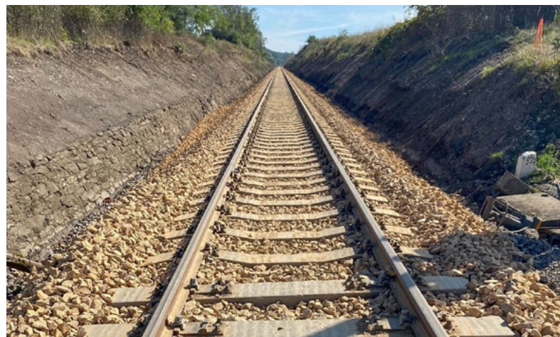
...a po opravě
