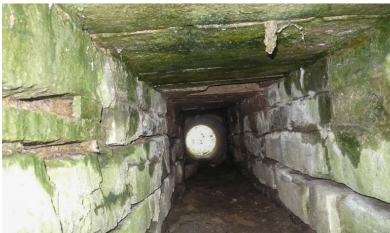
Stav před opravou...
