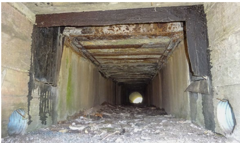
Stav před opravou...
