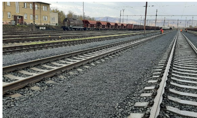
...a po opravě
