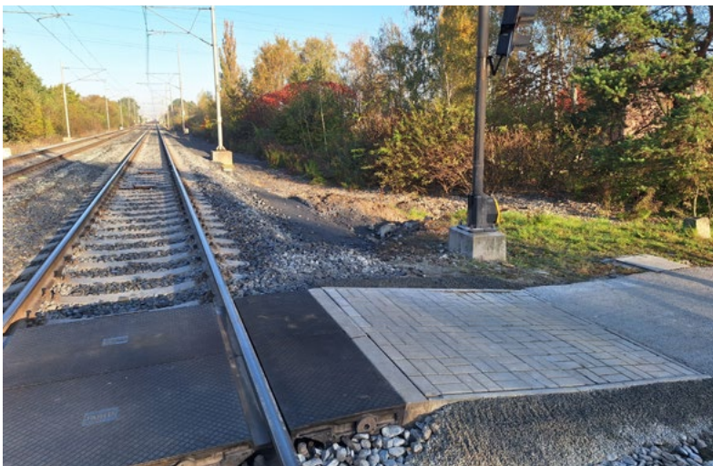
...a po opravě
