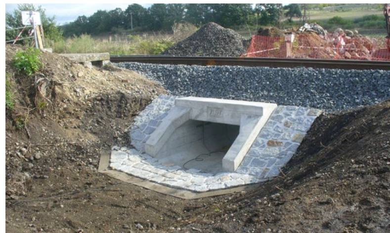
...a po opravě
