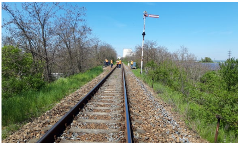
Stav před opravou...
