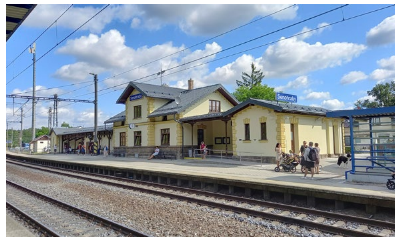
...a po opravě
