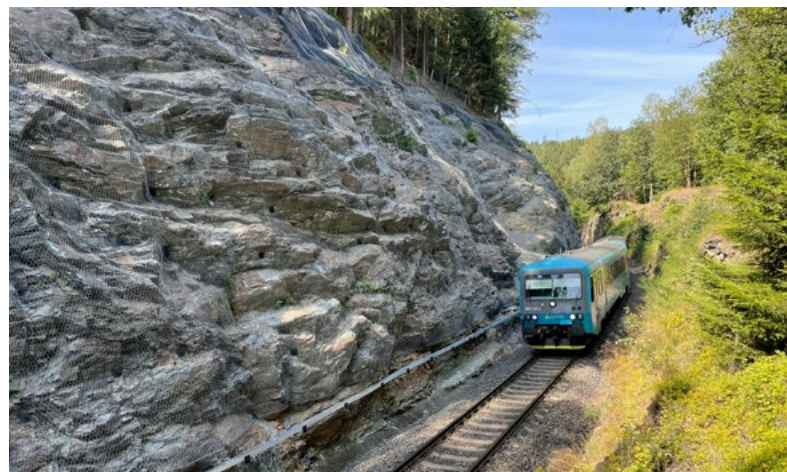
...a po opravě
