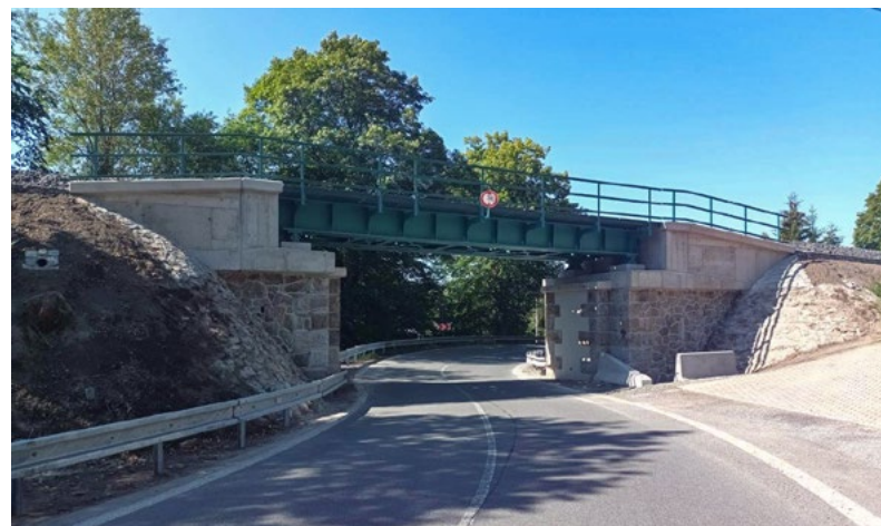
...a po opravě
