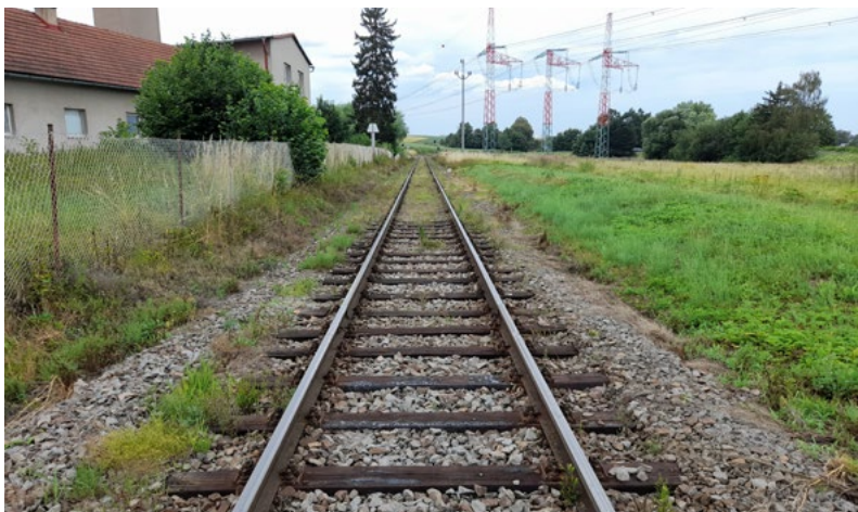
Stav před opravou...
