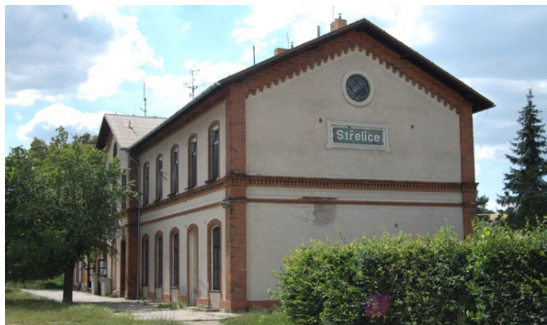
Stav před opravou...
