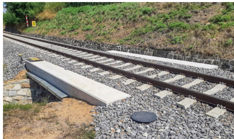
...a po opravě
