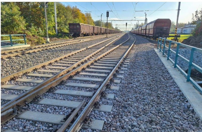
...a po opravě
