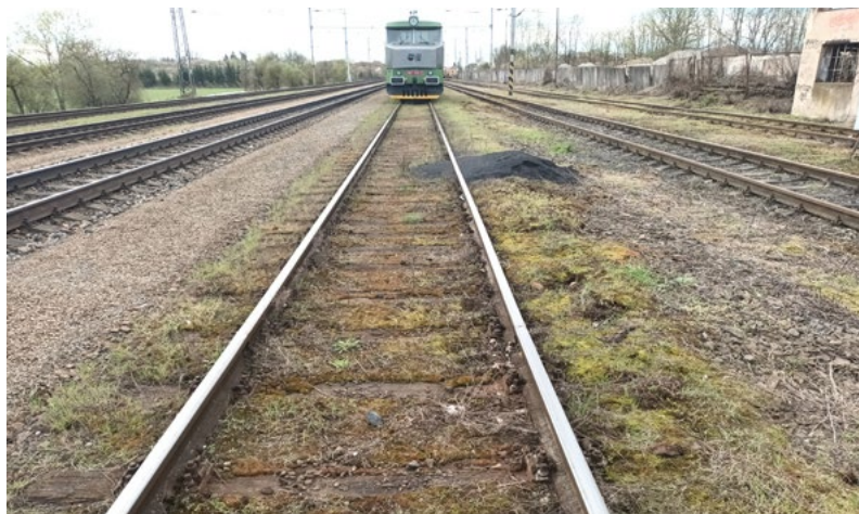
Stav před opravou...
