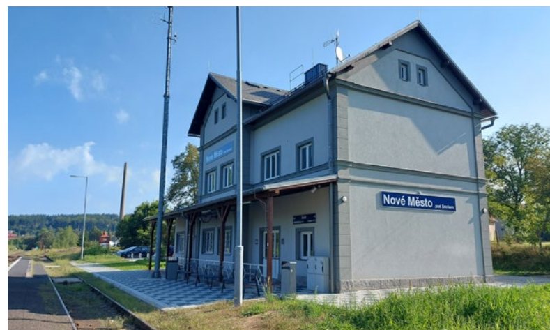
...a po opravě
