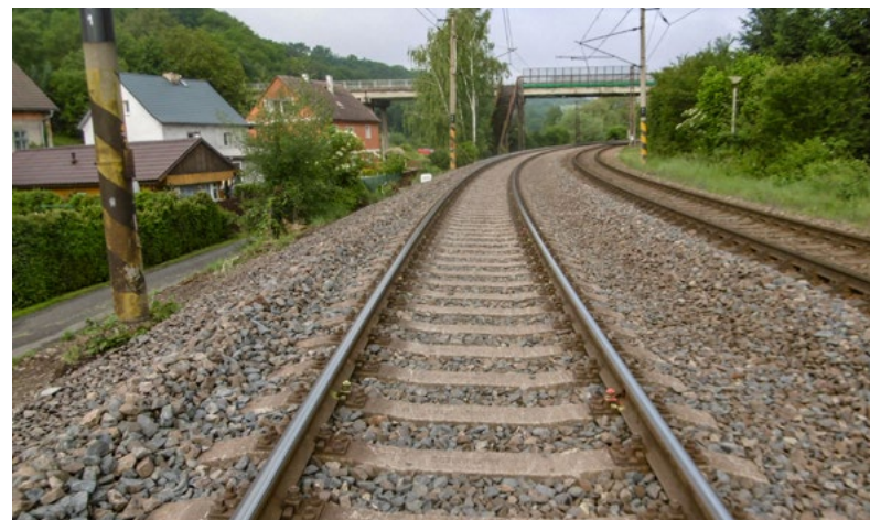
...a po opravě
