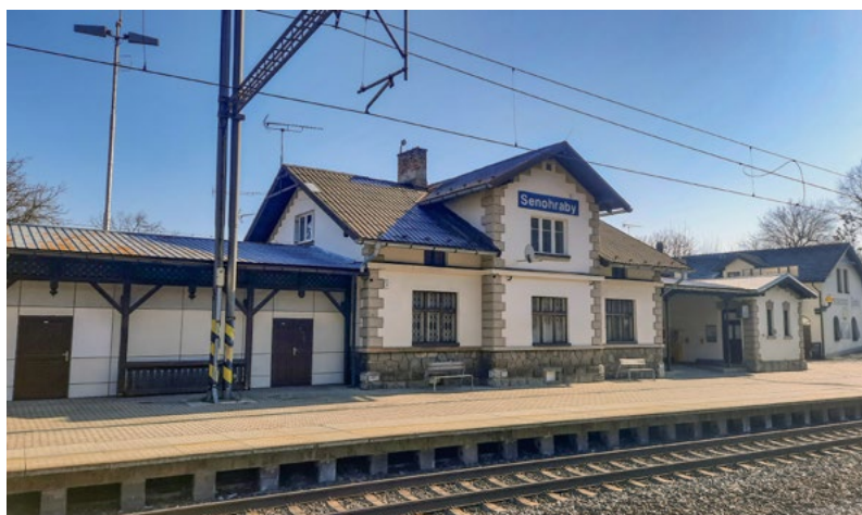
Stav před opravou...
