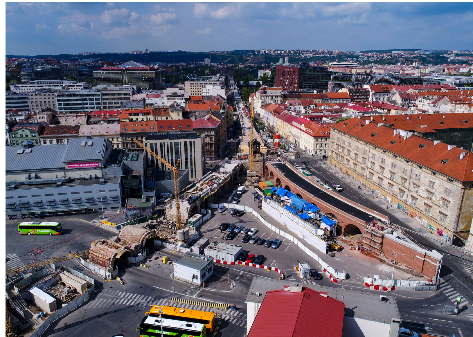
Pohled na rozebrané mostní klenby v prostoru autobusového nádraží Florenc
