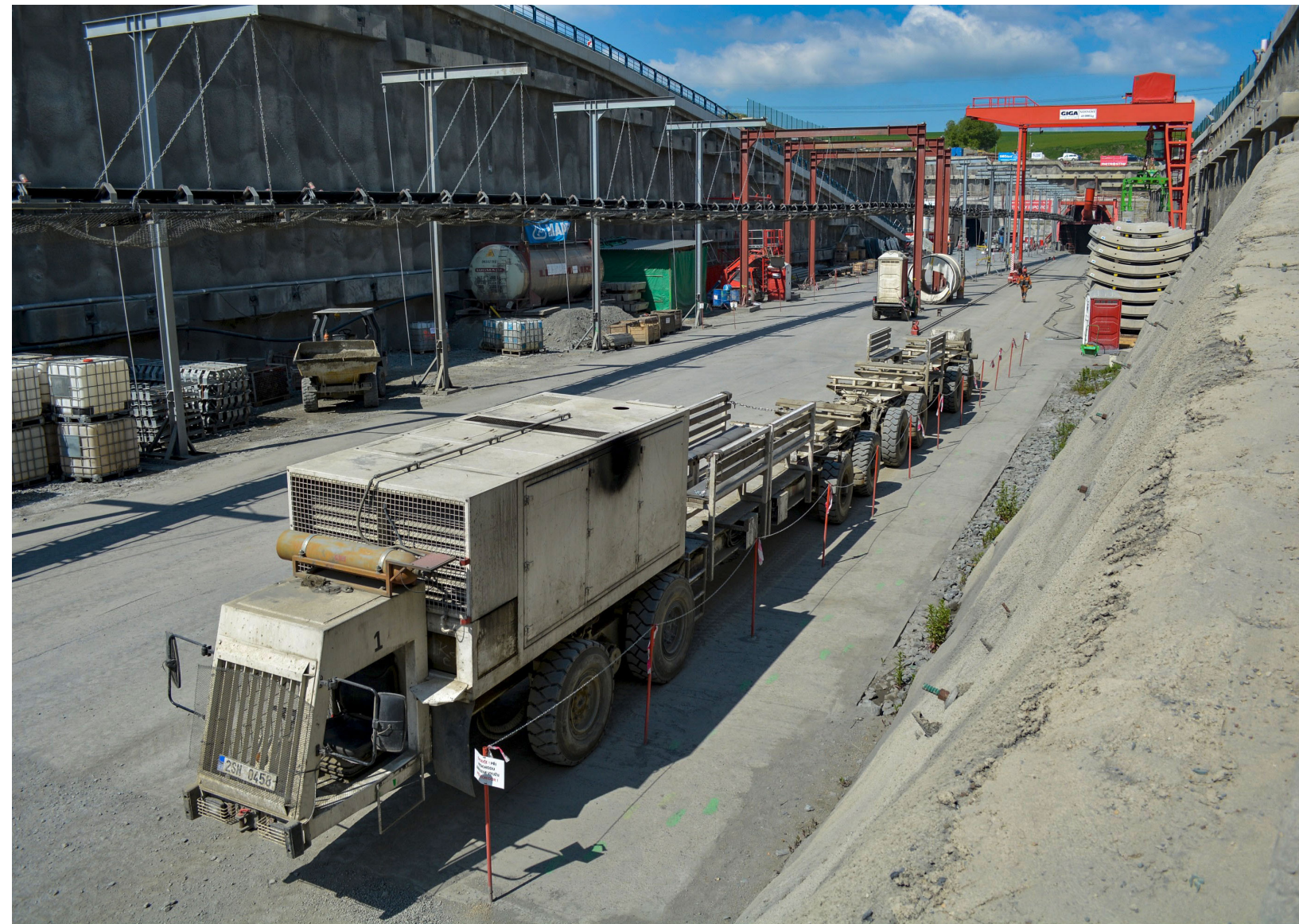
Předportálí tunelů ražených metodou TBM (foto z Ejpvických tunelů)
