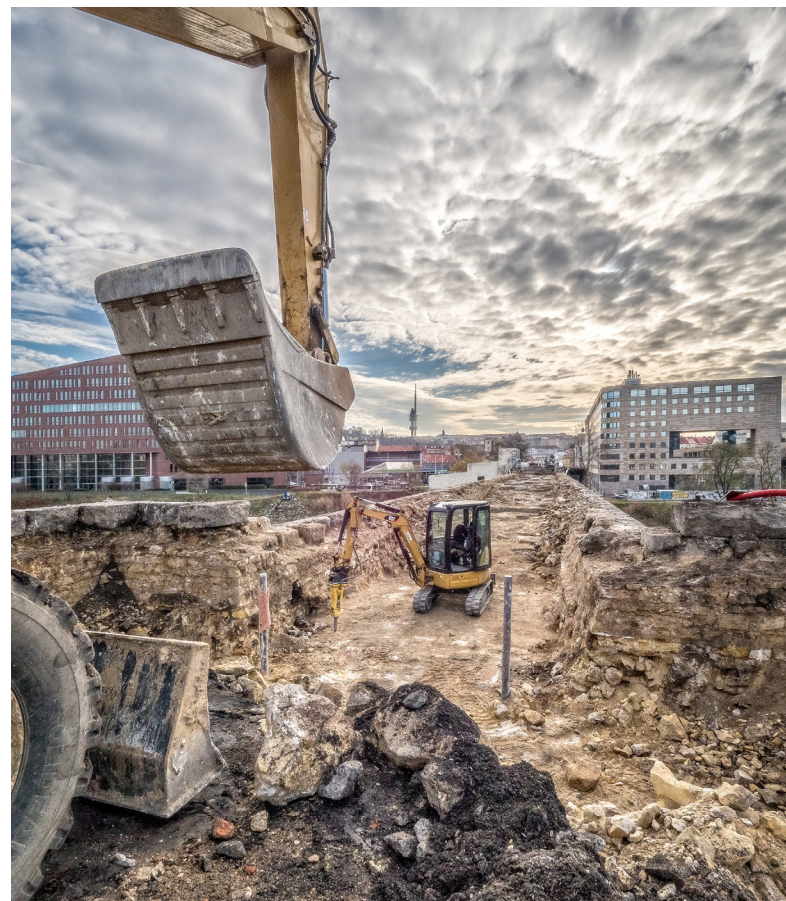
Rekonstrukce Negrelliho viaduktu
