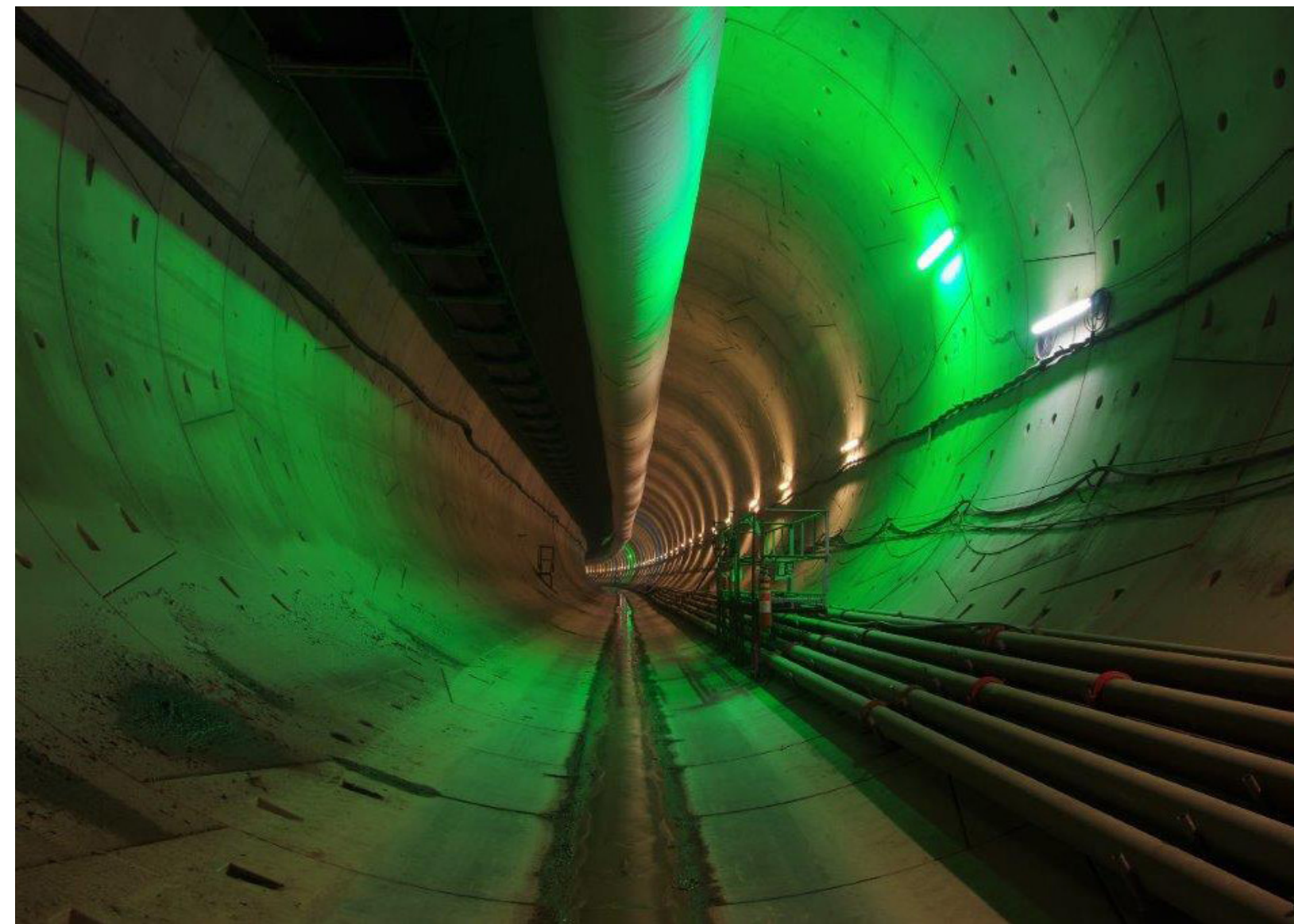
Rážba tunelu bude prováděna s pomocí plnoprofilových razících strojů (TBM)
