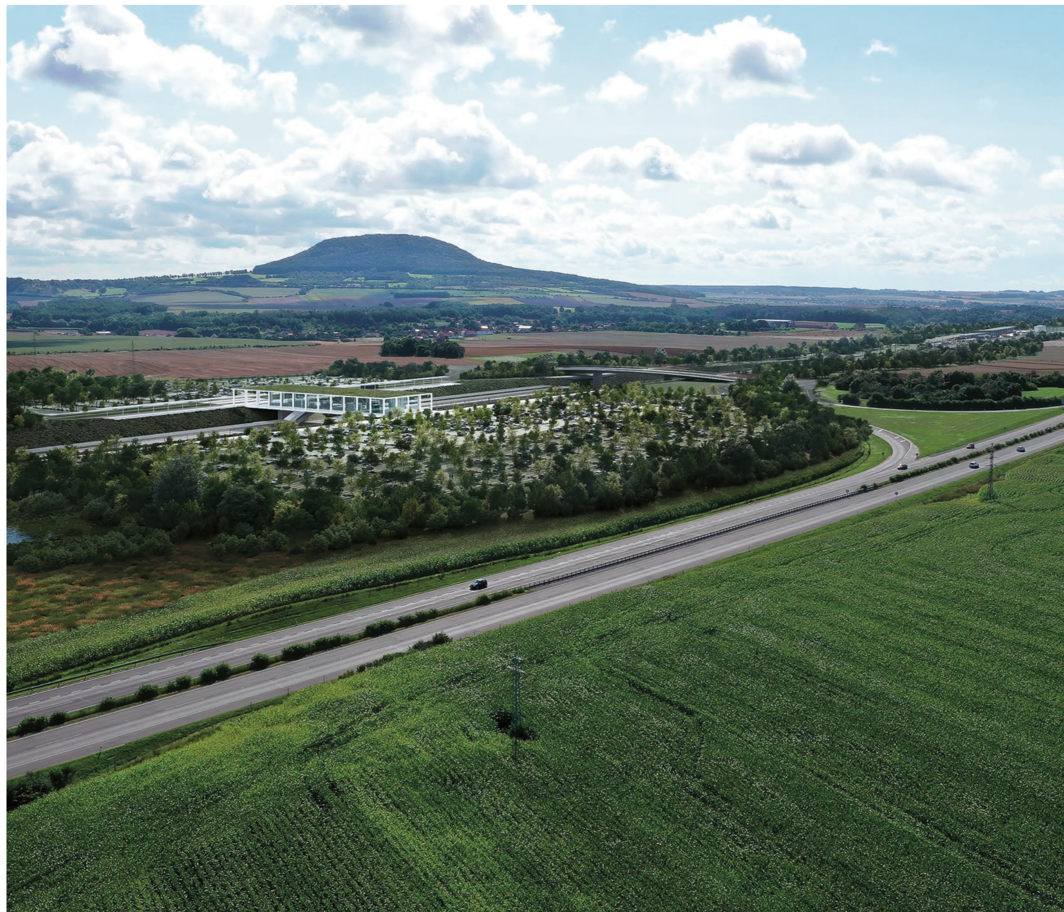
Terminál VRT – Roudnice nad Labem
