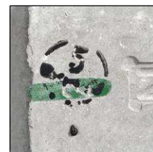
Barevné značení rozšíření rozchodu koleje * (jeden barevný pruh značí rozšíření rozchodu koleje o 2,5 mm na příslušné úložné ploše pražce)
