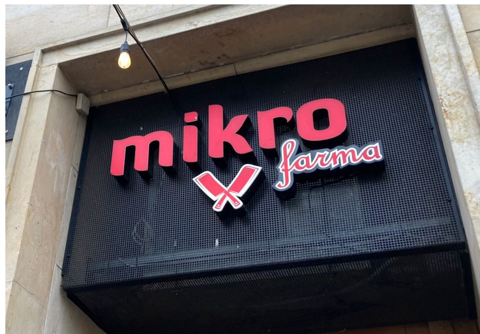
Příklad zakrytí klimatizace plechem s nainstalovaným logem provozovny z hliníku a plexiskla s prosvícením. Jde o vizuální ukázkou z terénu, materiálem je zde tahokov místo perforovaného plechu.
