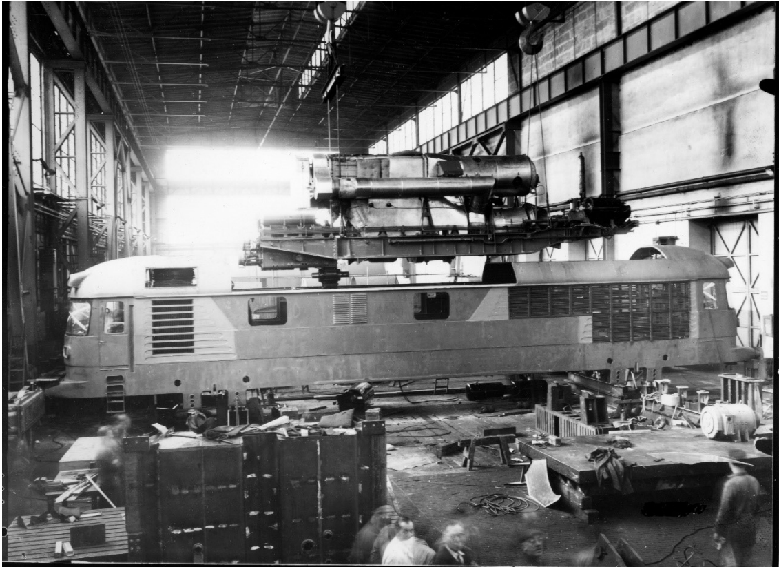
Obrázek č. 6: Turbínová lokomotiva TL 659.0 byla bezesporu krásná a technicky mimořádně zajímavá, což dosvědčuje i tento snímek z montážní haly LZ v Plzni. Je na něm zachycena instalace hnacího turbínového agregátu do strojovny první lokomotivy. Zdroj: Státní oblastní archiv v Plzni, fond Škoda Plzeň, fotografická dokumentace
