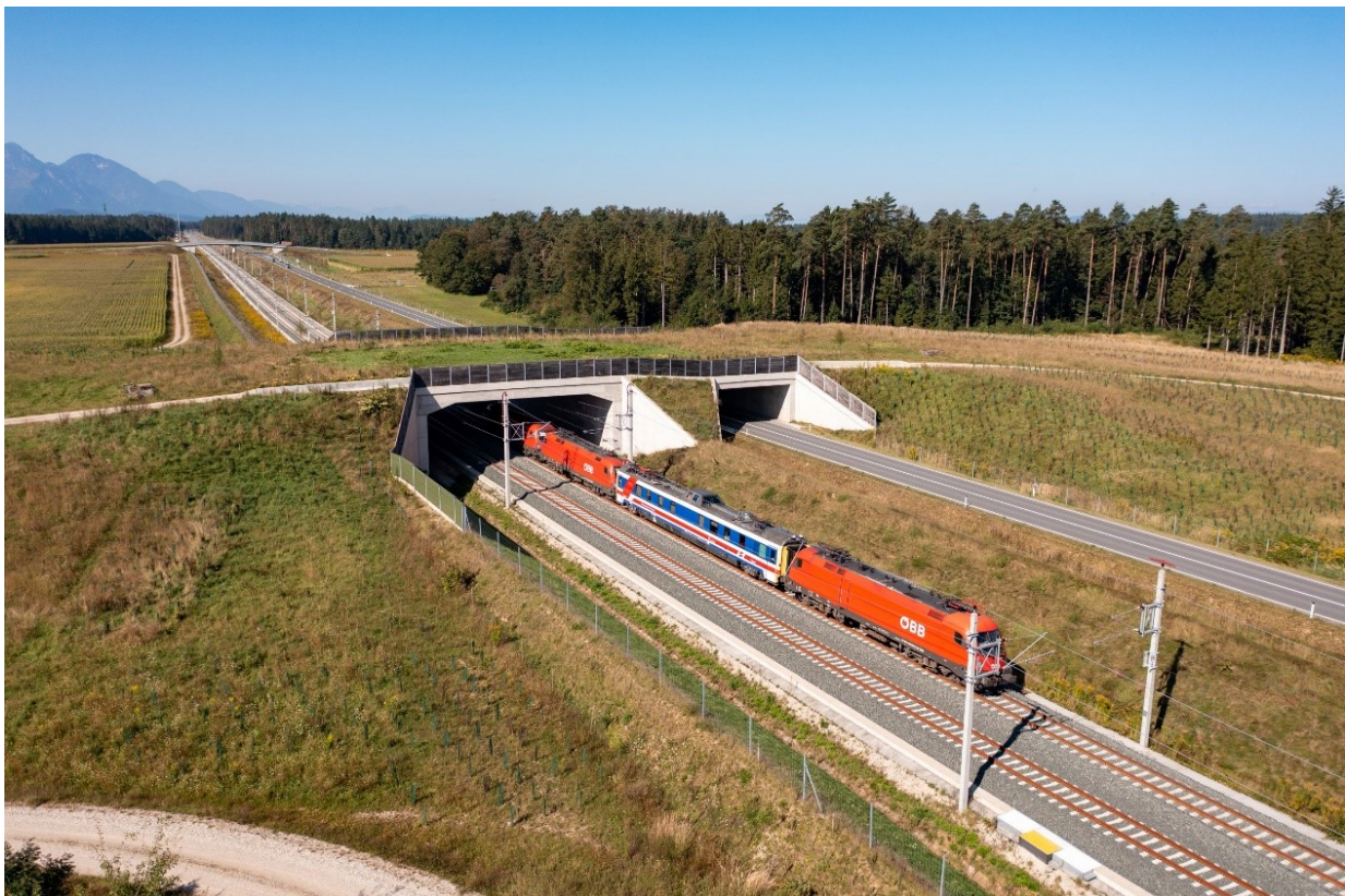
Foto 15: Měřicí vlak pro trakční napájení v září 2023 Zdroj: ÖBB-Infrastruktur AG [23]
