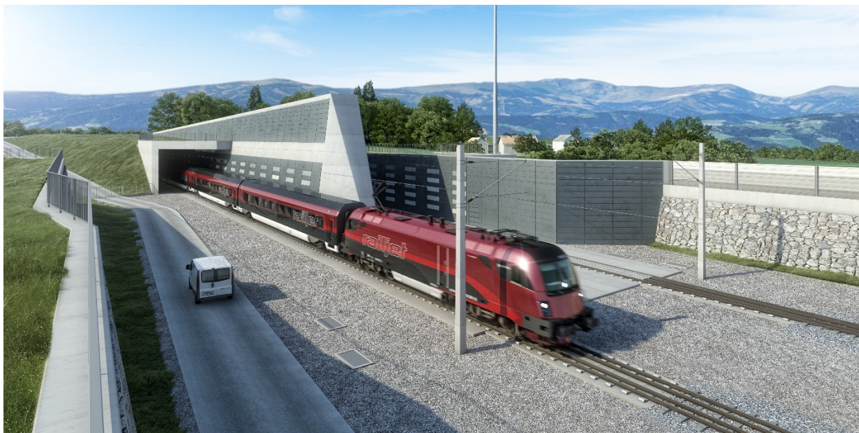
Foto 1: Vizualizace východního portálu (na štýrské straně) Koralmského tunelu Zdroj: ÖBB-Infrastruktur AG [6]
