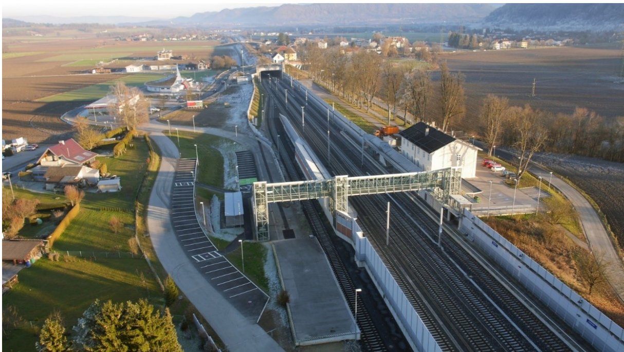
Foto 14: Dokončení nové železniční stanice Bahnhof Grafenstein , v pozadí zakrytí Grafenstein (rok 2016)
