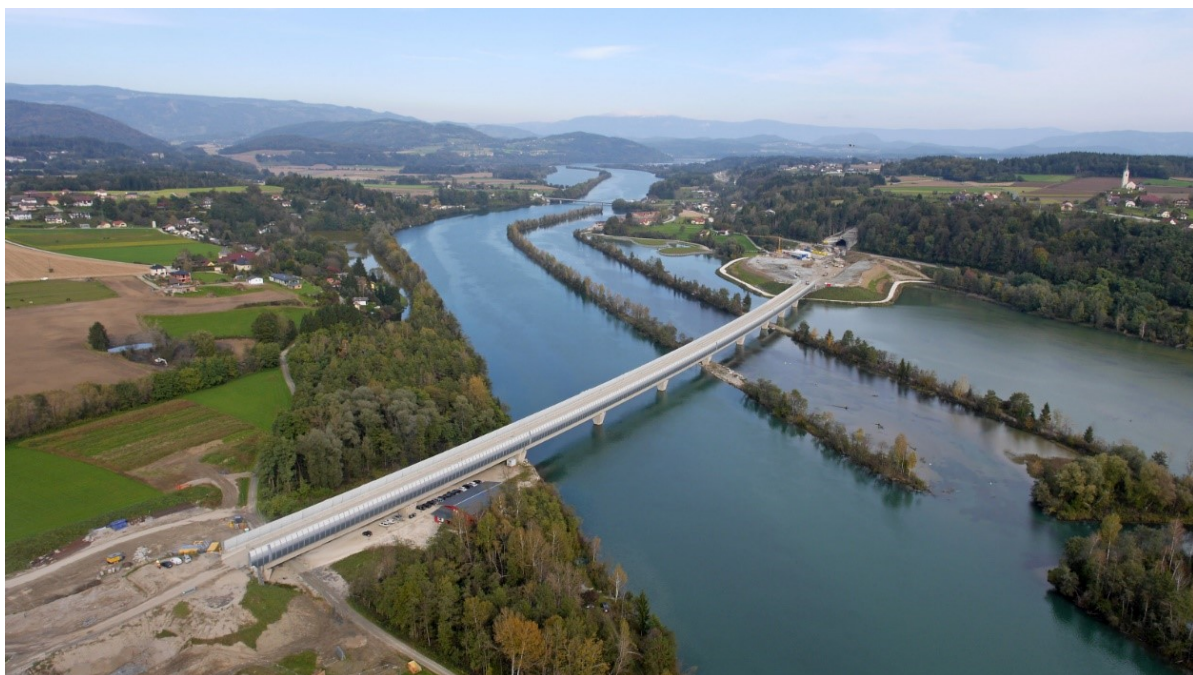
Foto 12: Výstavba nového mostu Draubücke (rok 2016) Zdroj: ÖBB-Infrastruktur AG [16]
