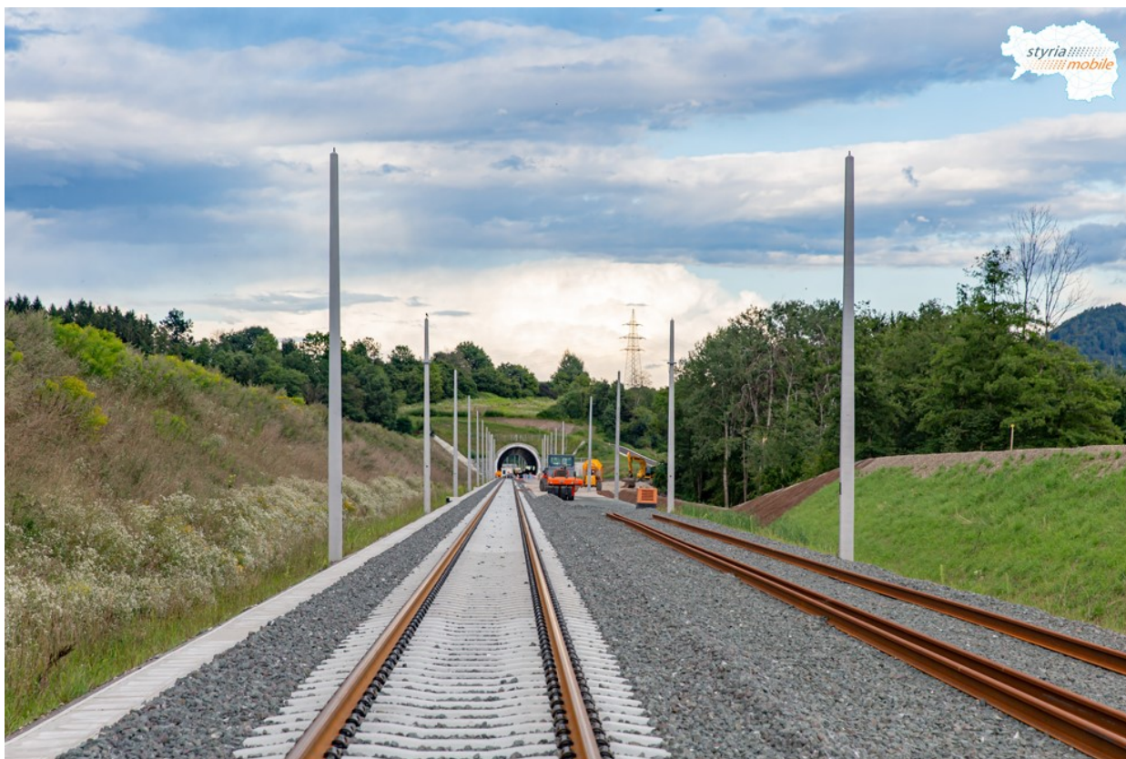
Foto 13: Výstavba železničního svršku, v pozadí portál tunelu Lind (říjen 2019) Zdroj: Styria-Mobile Forum [10]
