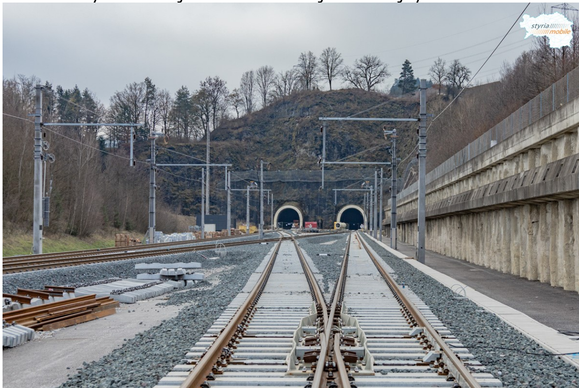
Foto 9: Staveniště železniční stanice Bahnhof Lavanttal , v pozadí západní portál Koralmského tunelu (prosinec 2022) Zdroj: Styria-Mobile Forum [10]
