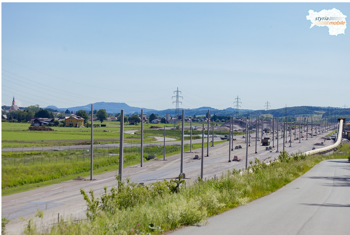
Foto 5: Stavba železniční stanice Bahnhof Weststeiermark (květen 2022) Zdroj: Styria-Mobile Forum [10]
