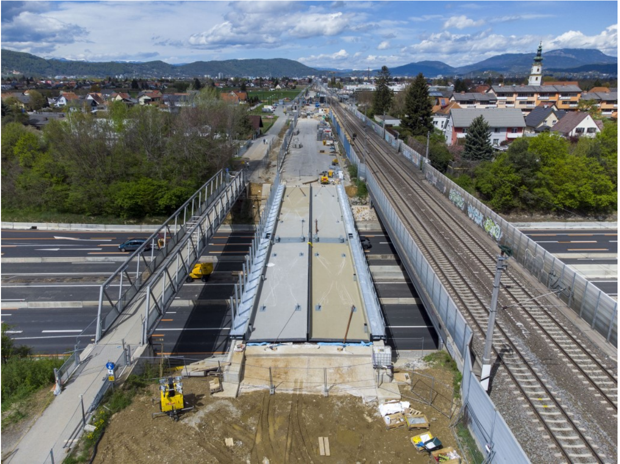
Foto 2: Výstavba nového dvoukolejného mostu Koralmské dráhy v obci Feldkirchen přes dálnici A2, vedle něj stávající most Jižní dráhy (rok 2020) Zdroj: Kratzer & Partner ZT GmbH/ ÖBB-Infrastruktur AG [9]
