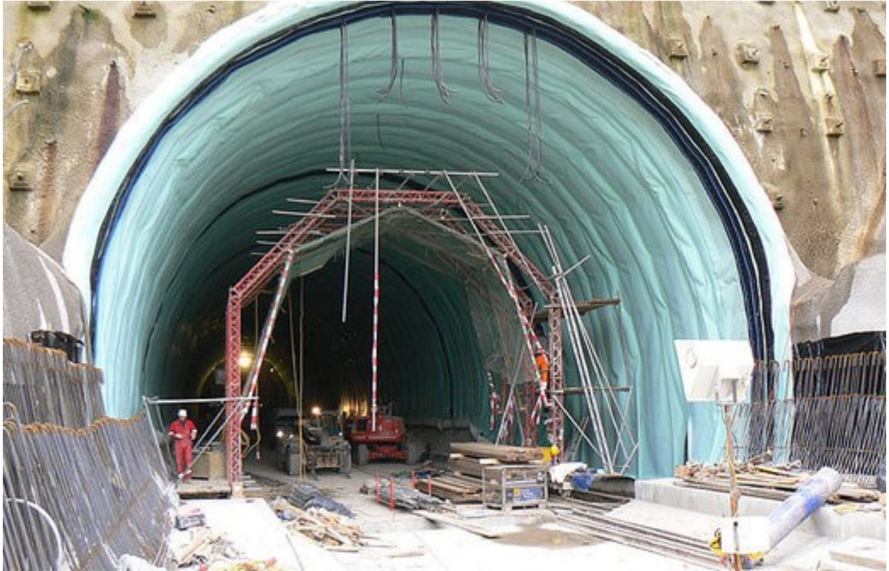
Foto 4: Výstavba tunelu Hengsberg (rok 2009) Zdroj: Robert Lenhard/Styria-Mobile Forum [12]
