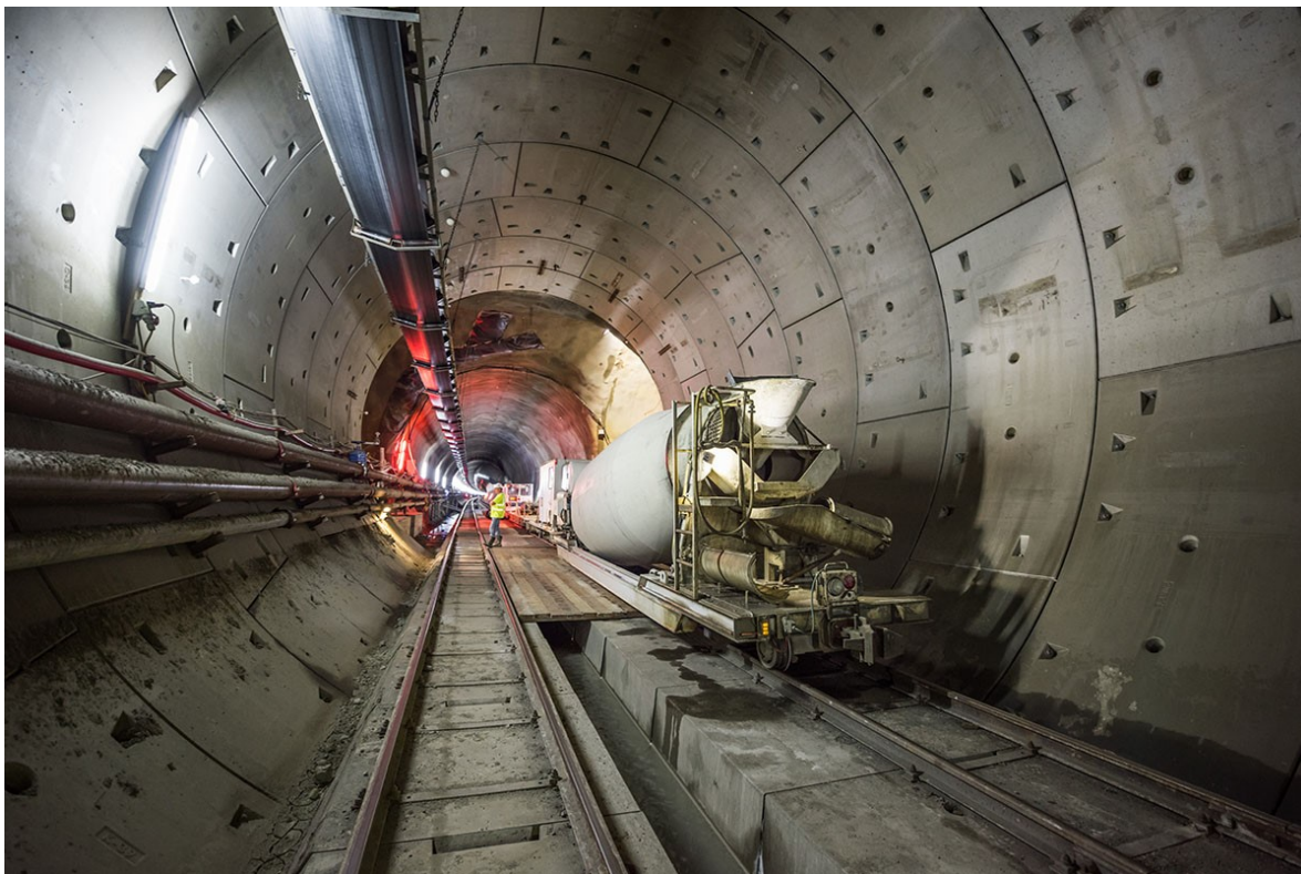
Foto 7: Výstavba Koralmského tunelu (rok 2017) Zdroj: ÖBB-Infrastruktur AG [16]
