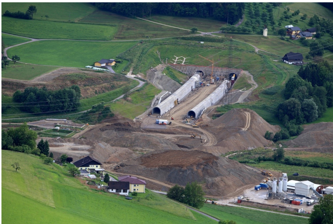
Foto 10: Výstavba komplexu tunelů Granitztal (rok 2016)
