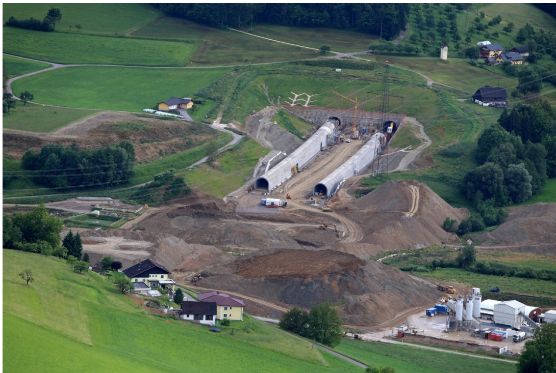
Foto 10: Výstavba komplexu tunelů Granitztal (rok 2016) Zdroj: ÖBB-Infrastruktur AG [16]
