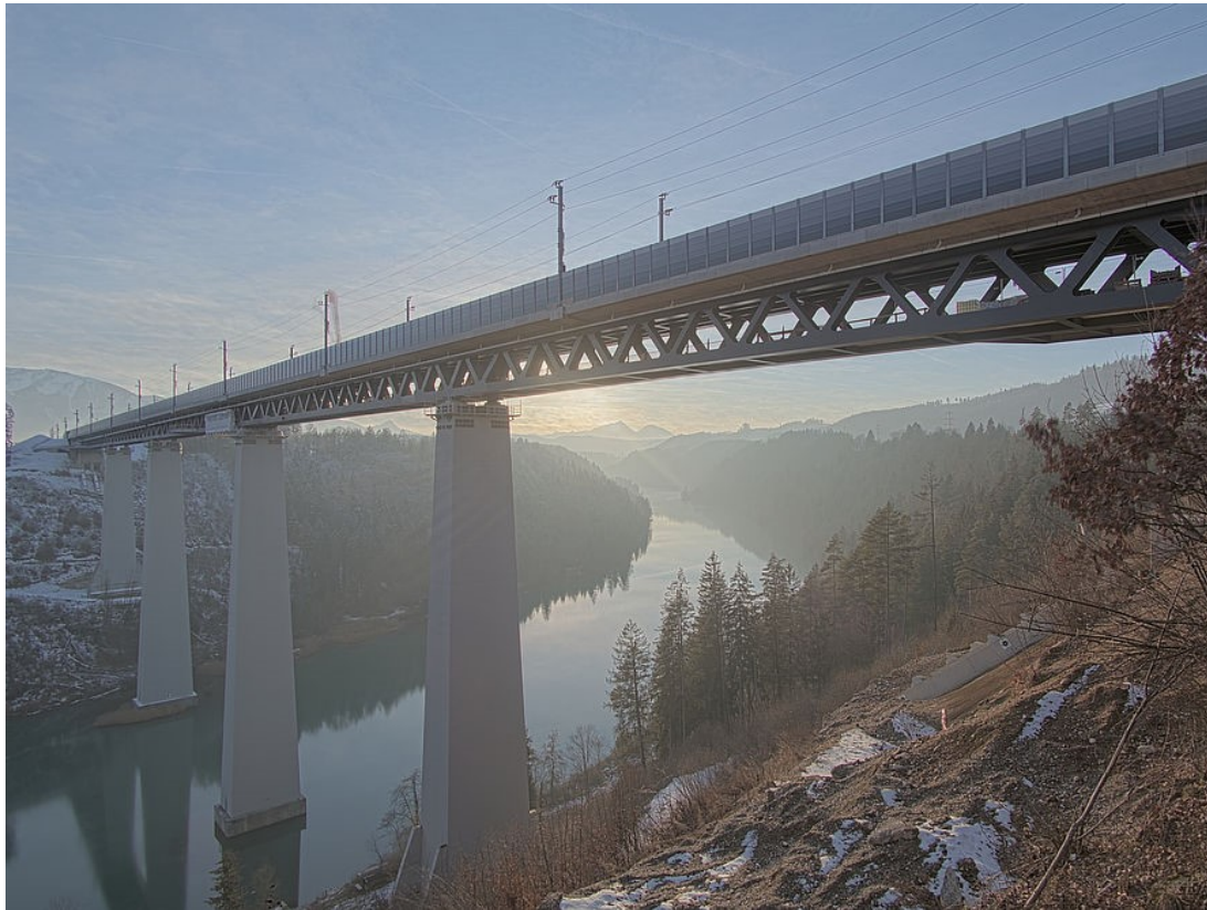
Foto 11: Dokončení nového mostu Jauntalbrücke (rok 2023) Zdroj: ÖBB-Infrastruktur AG [16]
