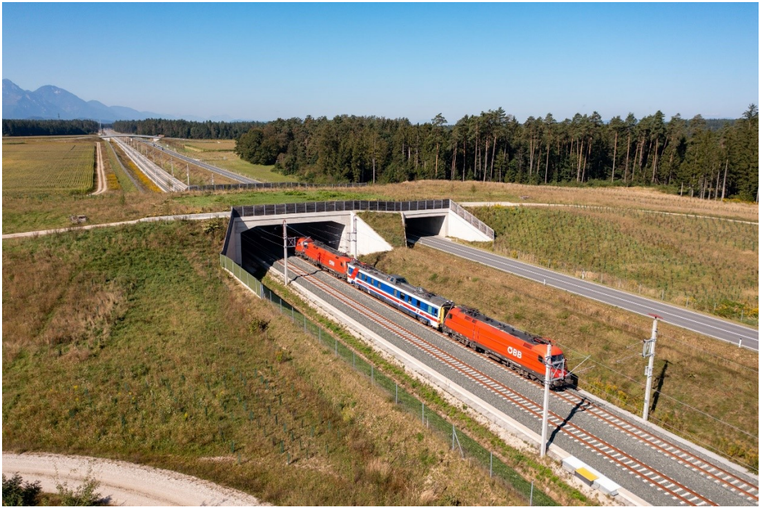
Foto 15: Měřící vlak pro trakční napájení v září 2023 Zdroj: ÖBB-Infrastruktur AG [23]
