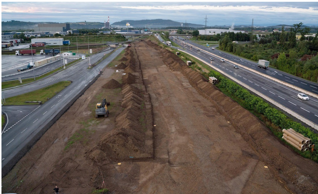
Foto 17: Odhalení římské říšské silnice v roce 2021 Zdroj: ÖBB-Infrastruktur AG [16]
