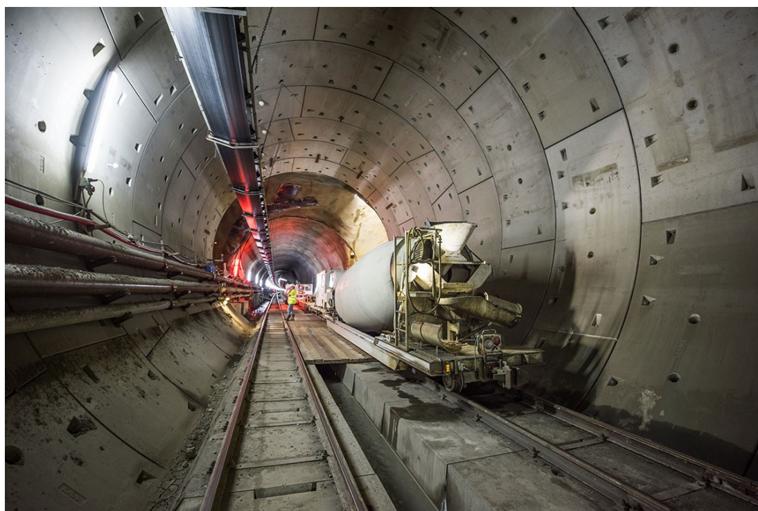
Foto 7: Výstavba Koralmského tunelu (rok 2017) Zdroj: ÖBB-Infrastruktur AG [16]
