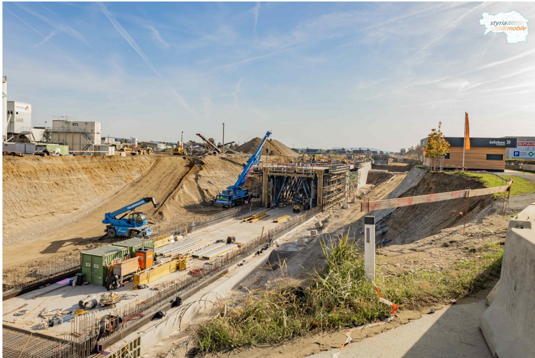
Foto 3: Stavba podzemní trasy Koralmské dráhy v obci Feldkirchen (říjen 2022) Zdroj: Styria-Mobile Forum [10]
