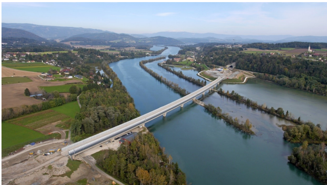
Foto 12: Výstavba nového mostu Draubrücke (rok 2016) Zdroj: ÖBB-Infrastruktur AG [16]
