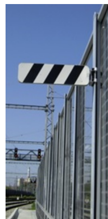
upevnění na zdi zboku
