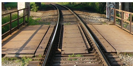
Obr. 13 Ukončení zajišťovacích úhelníků
