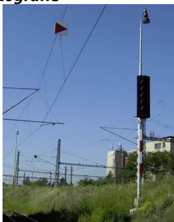
upevnění na nosném laně trakčního vedení
