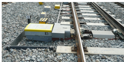
Přestavník s číslem výhybky 15, "hříbek" na ohrádce s číslem výhybky.
