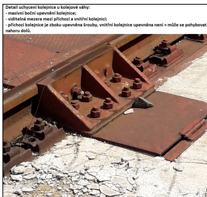
Detail uchycení kolejnice u kolejové váhy ("pucka").
