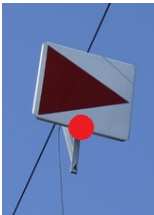
detail - upevnění na nosném laně trakčního vedení
