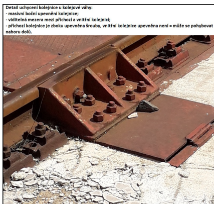
Detail uchycení kolejnice u kolejové váhy ("packa").
