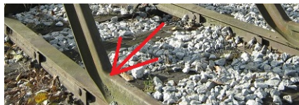
Detail - místo ohybu kolejnice, ke kterému se přikládá rozchodka.
