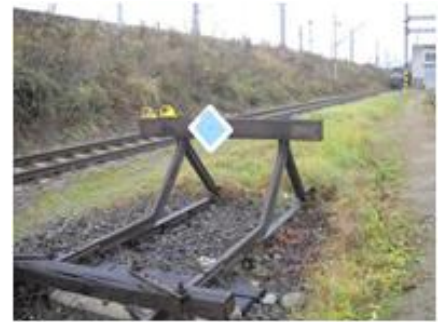
Kolejnicové zarážedlo se zakotveným dřevěným pražcem.
