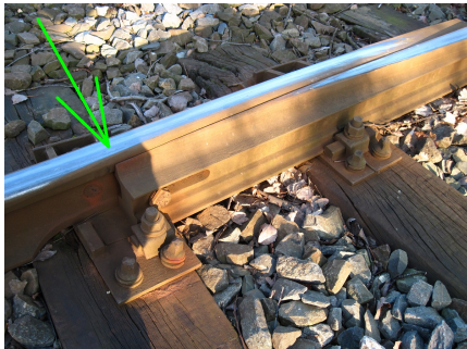
šipka označuje místo přiložení rozchodky pro zaměření pohyblivé části KDZ
