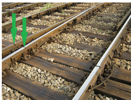
nejbližší styky za srdcovkou, zelená šipka ukazuje místo přiložení rozchodky
