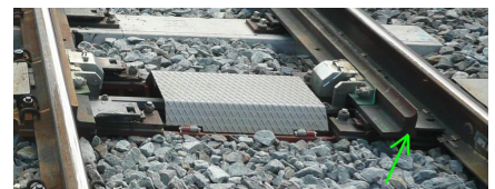
detail - místo přiložení rozchodky, pokud ve stojině není díra
