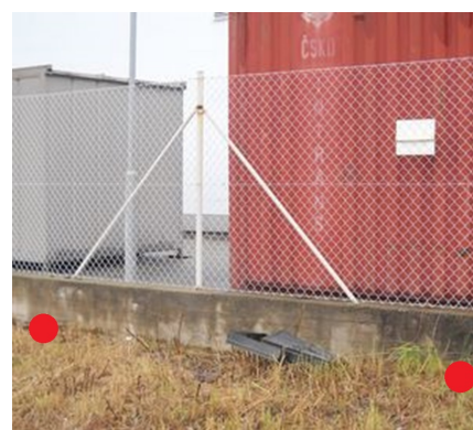
plot drátěný s podezdívkou s šířkou do 40 cm (včetně)
