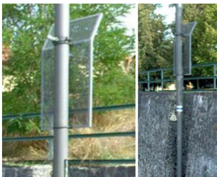
ochranná síť upevněná na trakční podpěře - neměřit, nesplňuje podmínky pro
