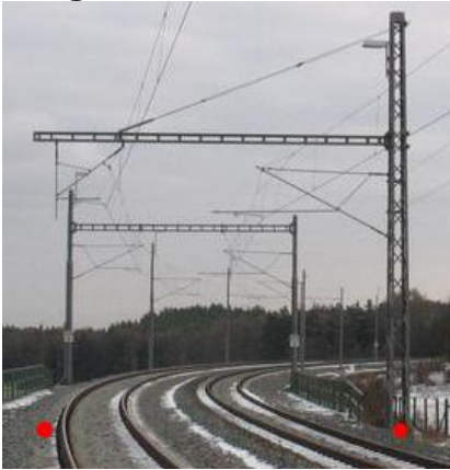
Brána poloviční (krakorec) upevněná na trakční podpěře.
