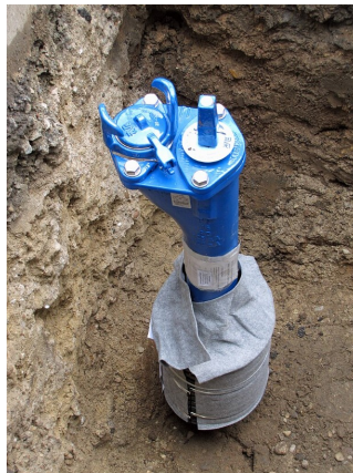
zdroj wikipedie, hydrant podzemní, atribut "v zemi / pod povrchem"
