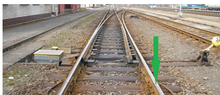
výměnový styk, zelená šipka ukazuje místo přiložení rozchodky
