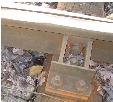
detail - ukázka přišroubování kolenové kolejnice k bočnici
