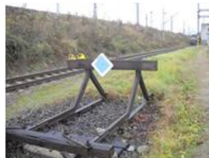
Kolejnicové zarážedlo se zakotveným dřevěným pražcem.
