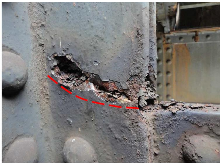
Koroze v přípojích svislic a diagonál ke styčnickovým plechům dolního pásu
