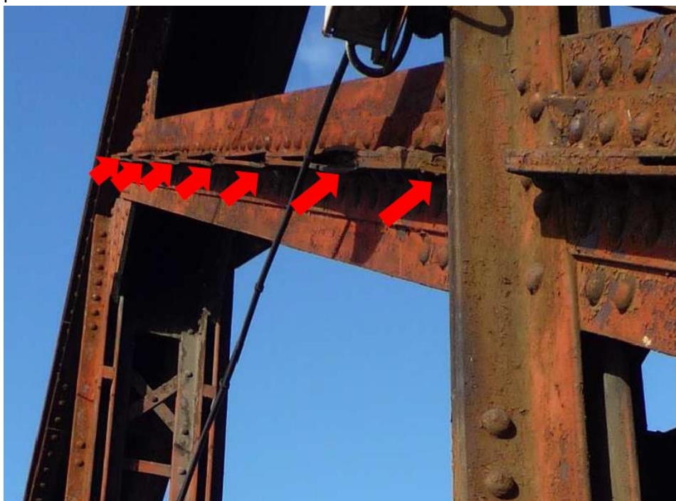
Silná štěrbinová koroze v přípojih spojek členěných prutů svislic a diagonál
