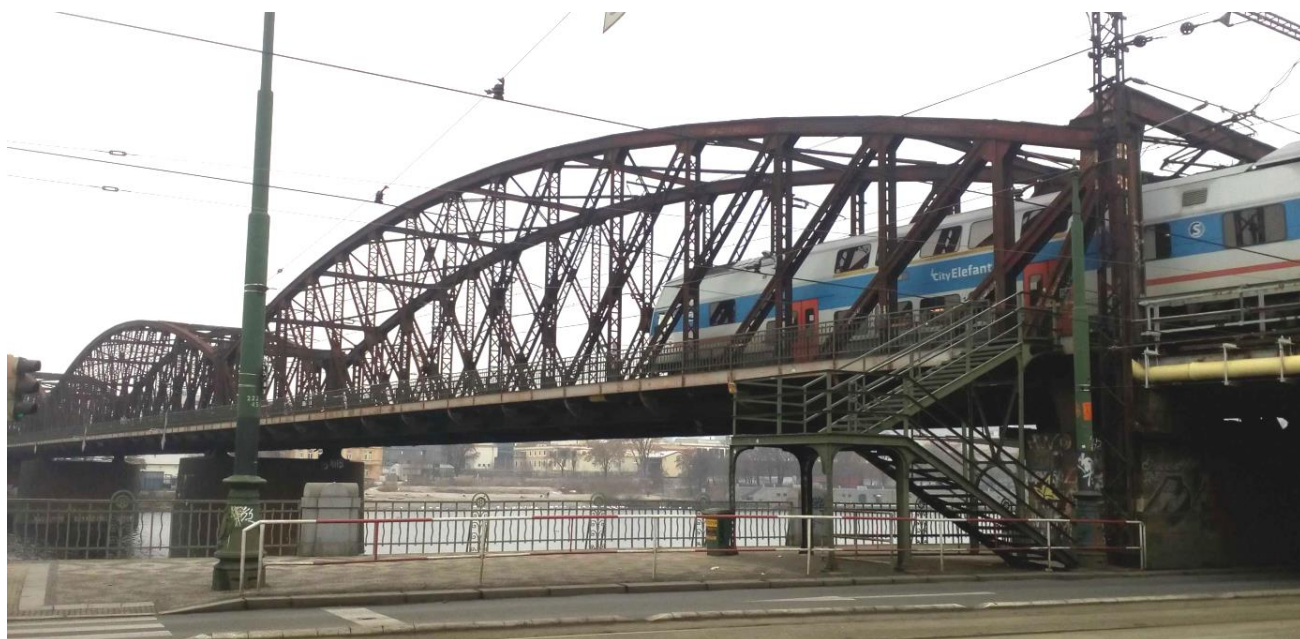
Pohled na železniční most přes Vltavu směr Smíchov
