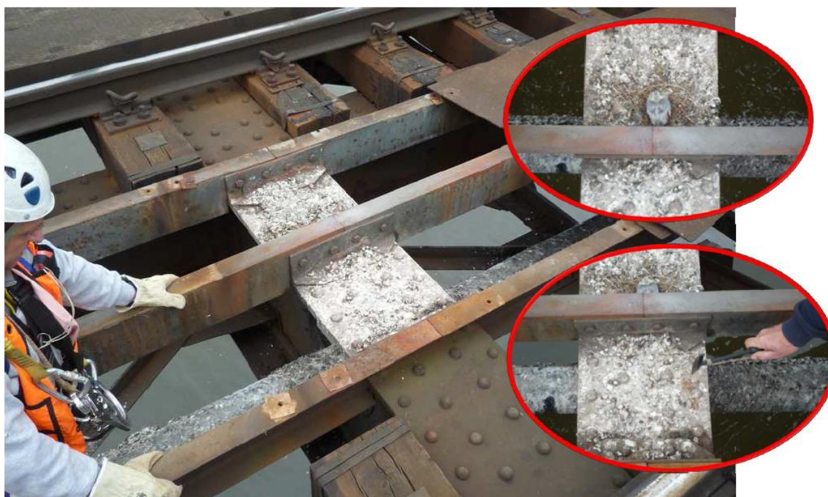
Koroze horních pásnic příčníků v důsledku působení holubího trusu
