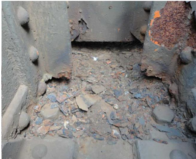
Koroze nadložiskových oblastí – portálová svislice
