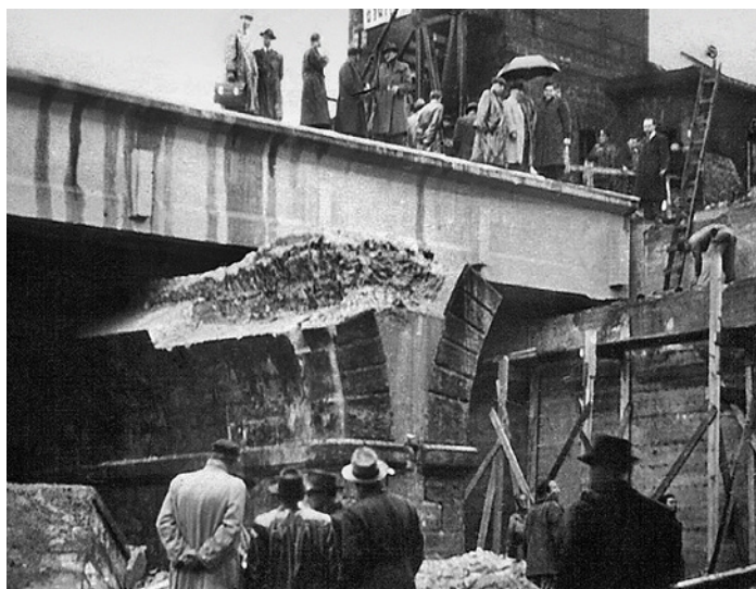
Obr. 3.6 – Železniční most přes ulici Křižíkovu v Praze – osazený trám v Praze-Karlíně; most v km 410,800 na TÚ 1501 Česká Třebová – Praha (v současné době je konstrukce nahrazena)
