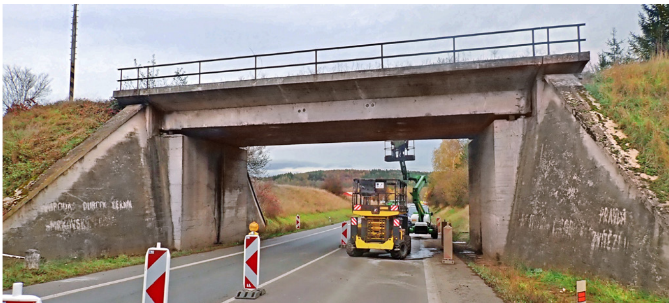
Obr. 3.119 – Železniční most přes silnici I/6 v Petrohradu – pohled; most v km 163,233 na TÚ 0502 Mladotice–Žatec
