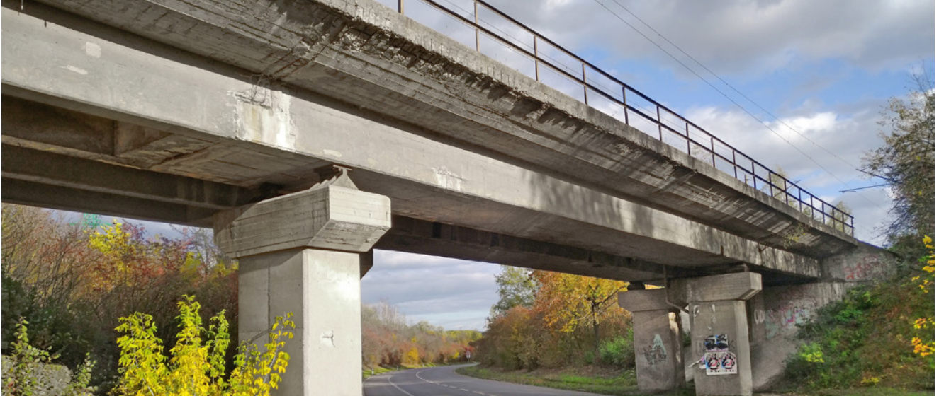
Obr. 3.131 – Železniční most přes ul. Želénská u obce Želénky – pohled zprava; most v km 28,440 na TÚ 0591 Ústí nad Labem – Most
