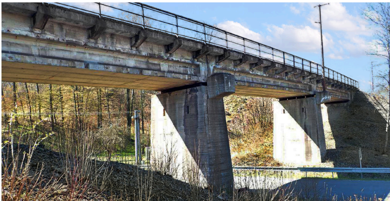
Obr. 3.101 – Železniční most Malý Gagarin u Českého Těšína – pohled; most v km 5,754 na TÚ 2521 Český Těšín – Ostrava-Kunčice
