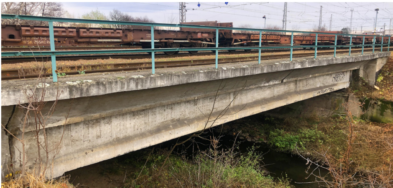
Obr. 3.106 – Železniční most přes řeku Vrchlice v Kutné Hoře – pohled; most v km 287,291 na TÚ 1201 Šatov–Kolín
