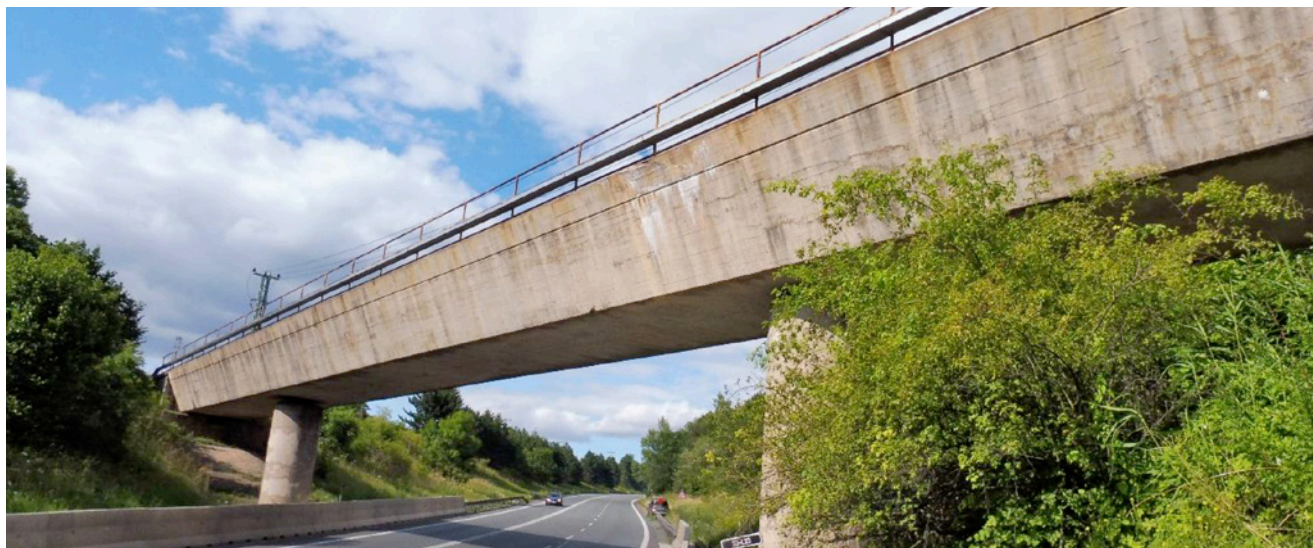
Obr. 3.122 – Železniční most přes silnici I/33 ve Vysokově – pohled; most v km 55,340 na TÚ 1561 Týniště nad Orlicí – Meziměstí
