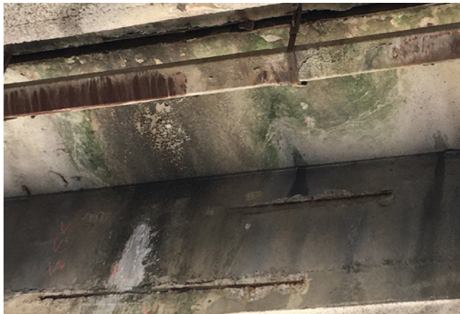
Obr. 3.113 – Vlevo: obnažená a korodující výztuž stěny monolitického nosníku na odvodňovací straně; stopy od vody a drobná vegetace od tekoucí vody po přírubě a stěně nosníku; vpravo: zatopená ochranná šachta opěry z důvodu zaneseného odvodnění; dolní vrubový kloub předpjatého táhla je vystavován vodě
