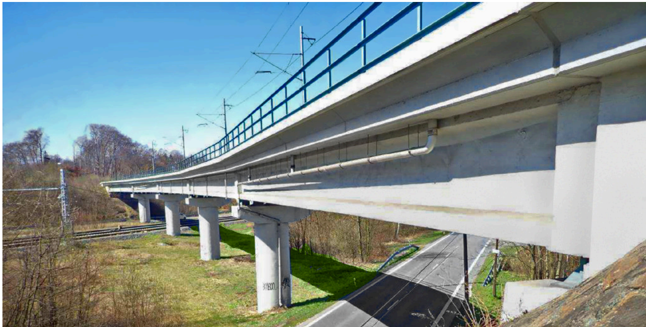
Obr. 3.100 – Železniční most Velký Gagarin u Českého Těšína – pohled; most v km 5,827 na TÚ 2521 Český Těšín – Ostrava-Kunčice
