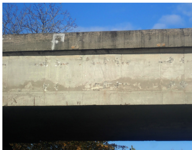
Obr. 3.128 – Vlevo i vpravo: Degradace povrchu betonu, lokální koroze odhalené výztuže
