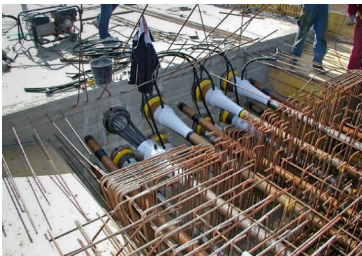
Obr. 2.25 – Cibulová kotva pro pasivní kotvení předpínací výztuže (podle Dywidag)
