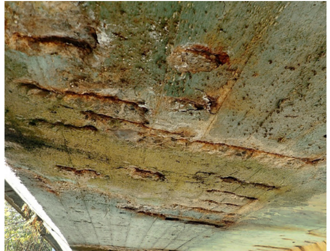
Obr. 3.90 – Typické poruchy nosníků T-66 - vlevo: koroze měkké výztuže v náběhu mezi stojinou a horní přírubou nosníku; vpravo: obnažená betonářská výztuž konzoly; most v km 12,805 na TÚ 0661 Velvěty–Kozlíky
