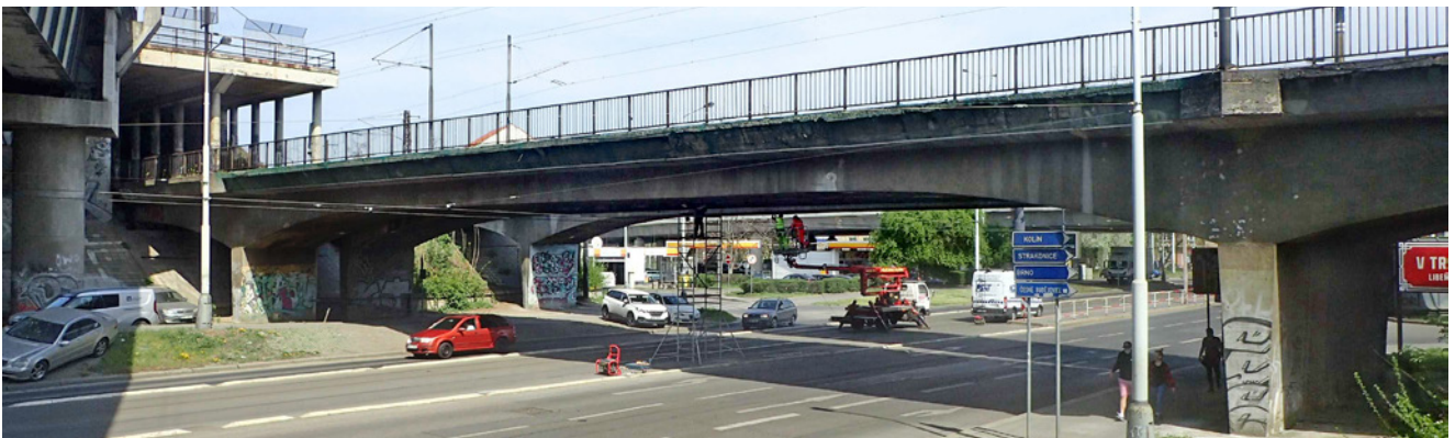
Obr. 3.110 – Železniční most přes ulici Sokolovská v Praze – pohled; most v km 0,397 na TÚ 0791 Praha-Libeň – Praha-Holešovice
