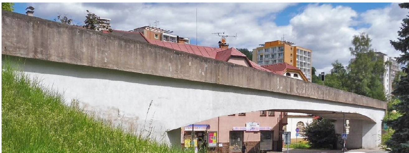
Obr. 3.136 – Železniční most v Železném Brodě – pohled; most v km 109,568 na TÚ 1051 Stará Paka – Liberec
