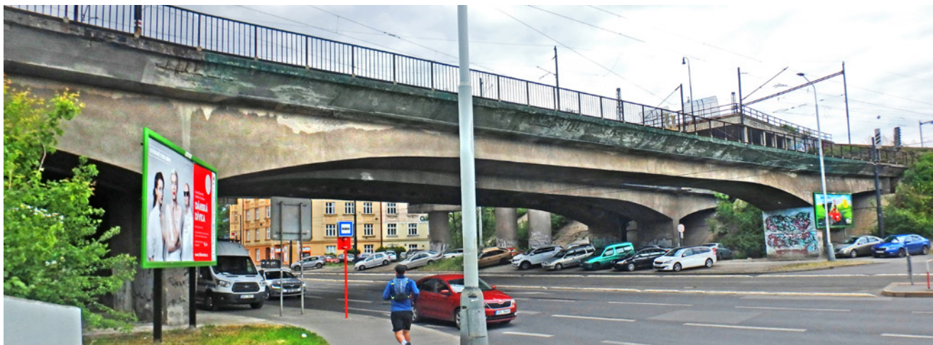
Obr. 3.114 – Železniční most přes ulici Sokolovská v Praze – pohled; most v km 0,230 na TÚ 0792 Praha-Libeň – Praha-Vysočany
