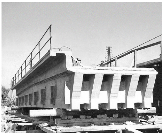
Obr. 3.8 – Železniční most přes řeku Výrovka v Pečkách – rošt sestavený z trámů; most v km 362,088 na TÚ 1501 Česká Třebová – Praha (v současné době je konstrukce nahrazena)
