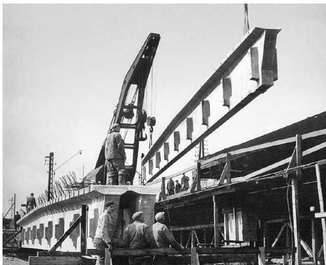
Obr. 3.7 – Železniční most přes řeku Výrovka v Pečkách – osazování trámů; most v km 362,088 na TÚ 1501 Česká Třebová – Praha (v současné době je konstrukce nahrazena)
