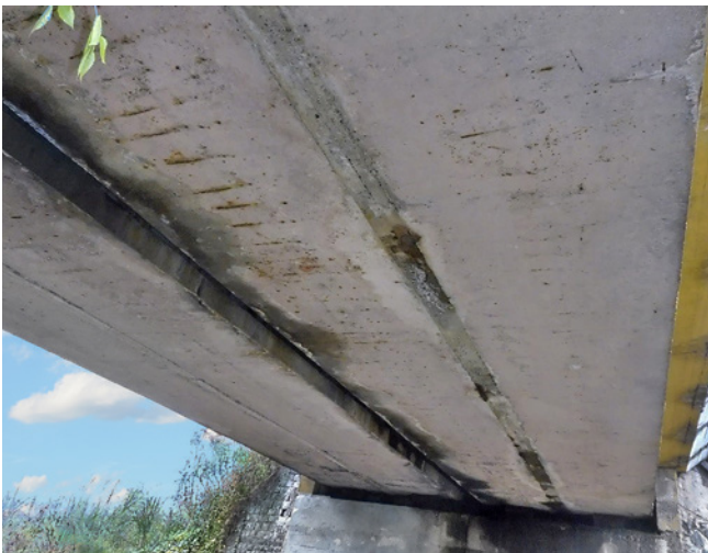
Obr. 3.91 – Typické poruchy - vlevo: výrazné stopy po zatékání skrz podélnou spáru mezi konstrukcemi, vápenné výluhy; vpravo: zrcadlo mezi konstrukcemi, stopy po zatékání, plošně odhalená a korodující betonářská výztuž; most v km 21,704 na TÚ 0661 – přes řeku Bílinu za obcí Hostomice
