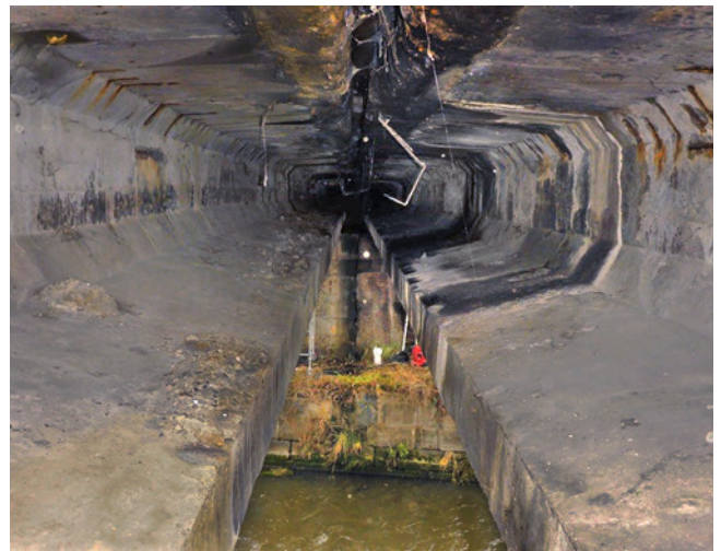
Obr. 3.91 – Typické poruchy - vlevo: výrazné stopy po zatékání skrz podélnou spáru mezi konstrukcemi, vápenné výluhy; vpravo: zrcadlo mezi konstrukcemi, stopy po zatékání, plošně odhalená a korodující betonářská výztuž; most v km 21,704 na TÚ 0661 – přes řeku Bílinu za obcí Hostomice
