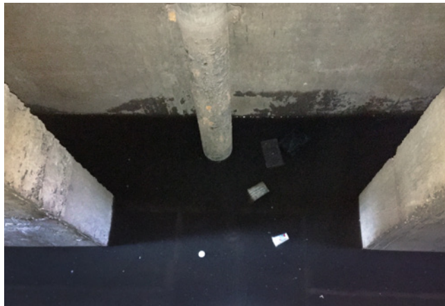
Obr. 3.113 – Vlevo: obnažená a korodující výztuž stěny monolitického nosníku na odvodňovací straně; stopy od vody a drobná vegetace od tekoucí vody po přírubě a stěně nosníku; vpravo: zatopená ochranná šachta opěry z důvodu zaneseného odvodnění; dolní vrubový kloub předpjatého táhla je vystavován vodě
