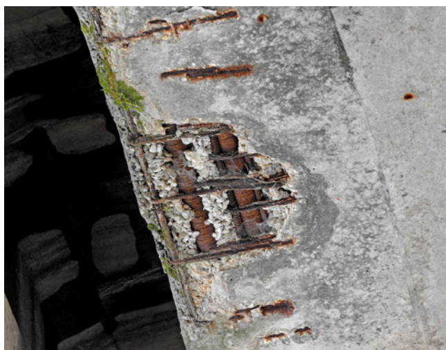
Obr. 4.31 – Železniční estakáda u Chabařovic – odhalené kabelové kanálky; most v km 10,798 na TÚ 0591 Ústí nad Labem – Most
