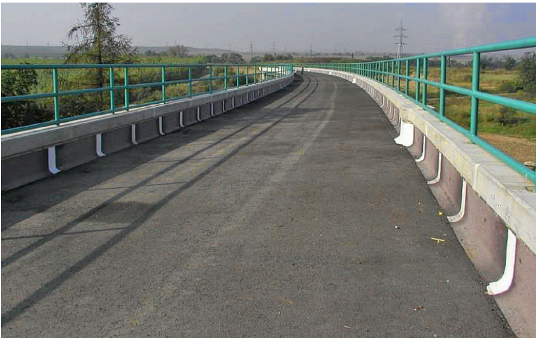
Obr. 2.44 – Monolitické železobetonové římsy
