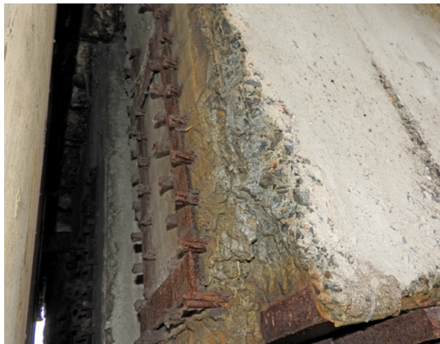
Obr. 4.37 – Železniční most přes řeku Chomutovku v Chomutově – čelo předem předpjaté konstrukce s viditelnými konci předpínací výztuže; most v km 0,593 na TÚ 0636 Chomutov-město – Chomutov-seřaďovací nádraží
