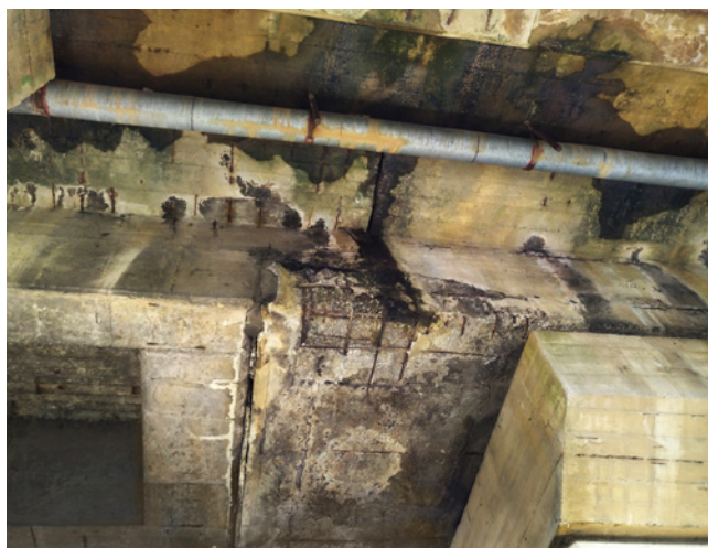
Obr. 3.135 – Vlevo: nejvýznamnější poruchou nosné konstrukce jsou podélné trhliny se stopami po průsacích, které kopírují trajektorii předpínací výztuže; vpravo: průsaky dilatačními spárami u vložených polí – dochází k hloubkové degradaci betonu, korozi výztuže, zatékání na kotevní oblasti předpínací výztuže
