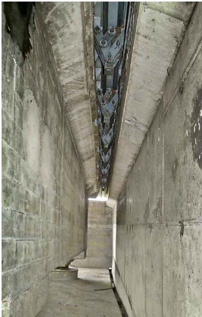
Obr. 4.37 – Železniční most přes řeku Chomutovku v Chomutově – čelo předem předpjaté konstrukce s viditelnými konci předpínací výztuže; most v km 0,593 na TÚ 0636 Chomutov-město – Chomutov-seřaďovací nádraží
