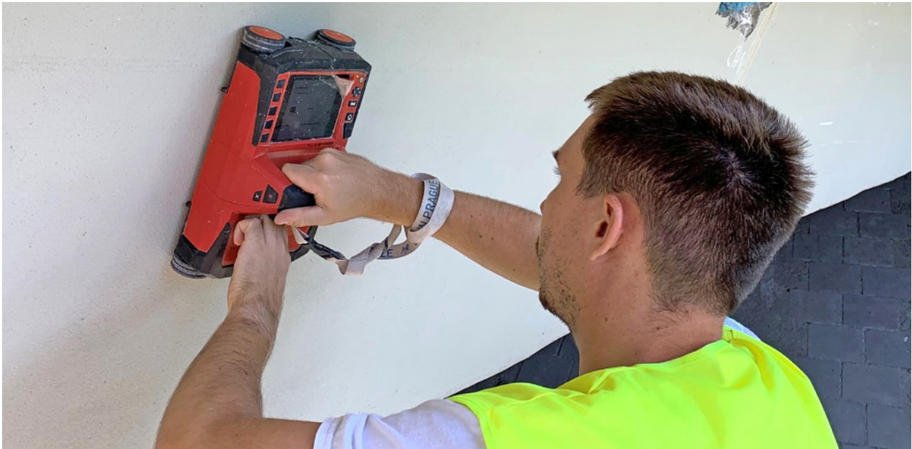
Obr. 5.18 – Hledání výztuže pomocí radaru
