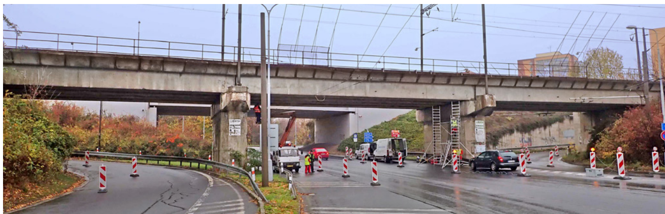
Obr. 3.75 – Železniční most přes silnici I/7 ul. Lipská v Chomutově – pohled; most v km 63,727 na TÚ 0602 Most–Chomutov
