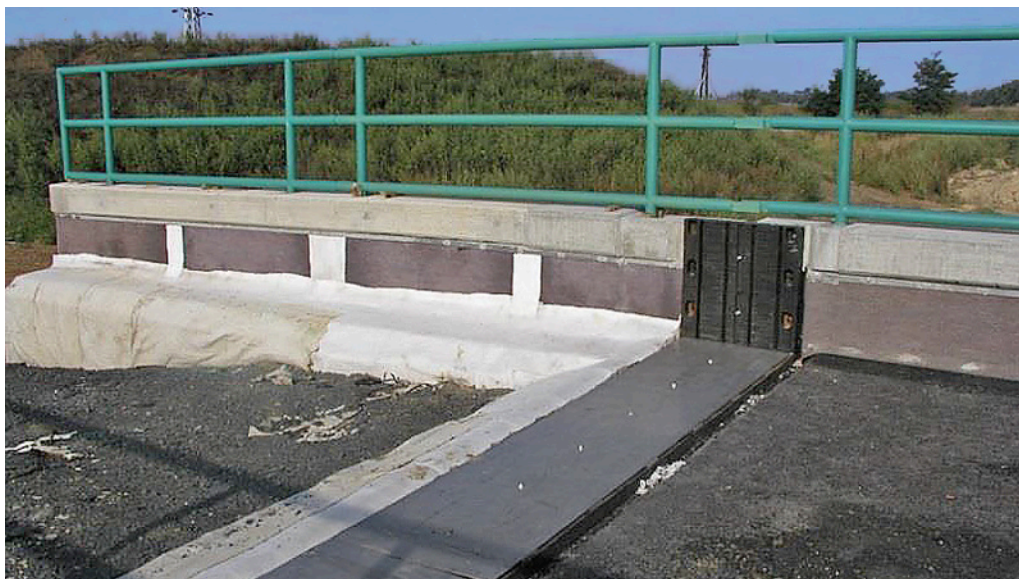
Obr. 2.38 – Železniční most v Březnu u Chomutova – ukončení nosné konstrukce mostním dilatačním závěrem (na vodorovné části závěru je již osazena krycí deska proti zapadávání zrn štěrku do mezer v mostním závěru); most v km 0,425 na TÚ 0101 Praha–Chomutov
