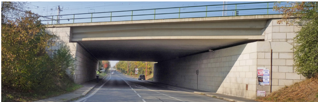
Obr. 3.105 – Železniční most přes silnici I/50H ul. Brněnská ve Starém Městě – pohled; most v km 137,608 na TÚ 2401 Břeclav–Přerov
