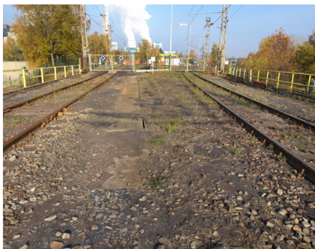
a) b) Obr. 3.32 – Železniční nadjezd elektrárny v Prunéřově (vlečkový most): a) pohled na most; b) povrch mostu (vlevo původní most, vpravo rozšíření)
