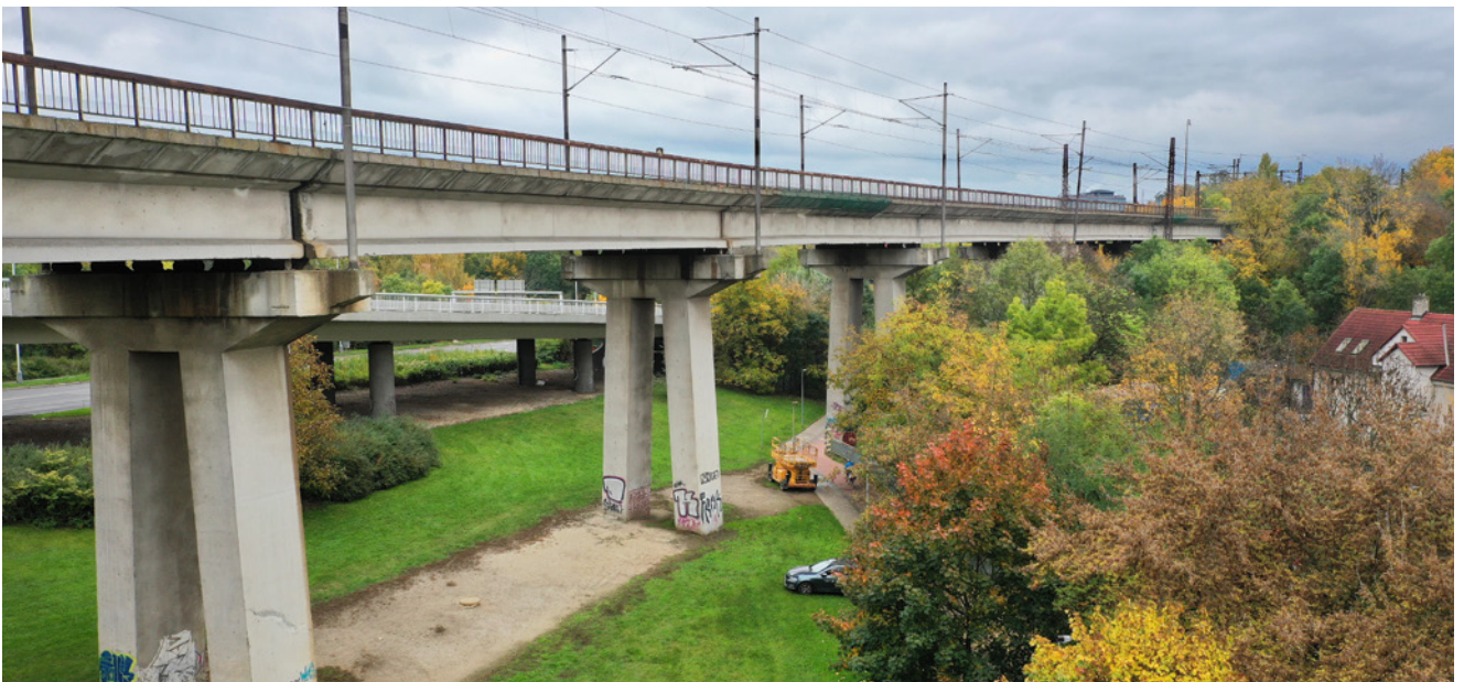
Obr. 3.98 – Železniční estakáda Rokytky v Praze – pohled; most v km 1,225 na TÚ 0791 Praha-Libeň – Praha-Holešovice
