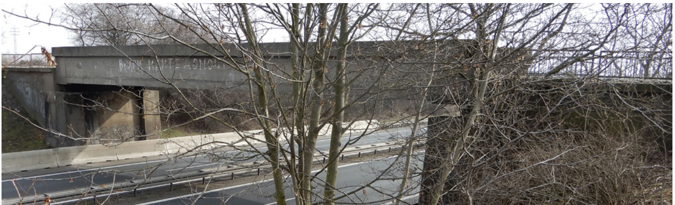
Obr. 3.125 – Železniční most přes dálnici D7 u Středokluk – pohled; most v km 28,063 na TÚ 0742 Středokluky–Podlešín
