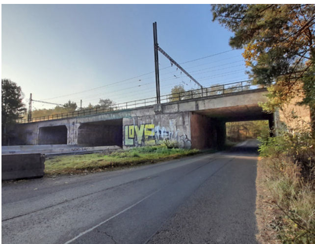
Obr. 3.14 – Železniční most přes dálnici D10 ve Staré Boleslavi: a) pohled od Mladé Boleslavi – původní předpjatá konstrukce je ve středním poli, z této strany je však viditelné pozdější rozšíření mostu; b) pohled od Prahy – detail (původní předpjatá je bližší konstrukce); most v km 348,054 na TÚ 0921 Lysá nad Labem – Všetaty
