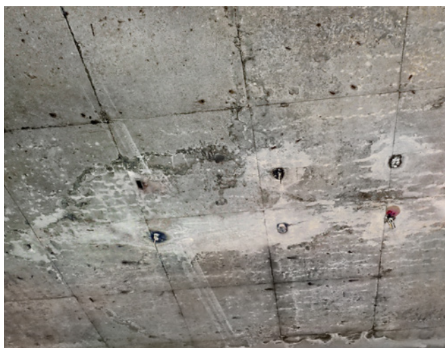
Obr. 3.128 – Vlevo i vpravo: Degradace povrchu betonu, lokální koroze odhalené výztuže
