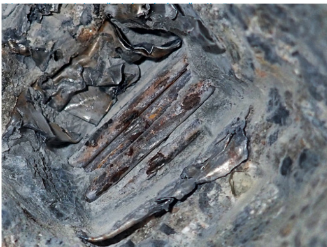
a) b) Obr. 5.211 – Destruktivní sonda k předpínací výztuži, a) zainjektovaný kanálek, b) nezainjektovaný kanálek [2-48]
