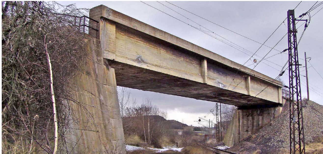
Obr. 3.129 – Železniční most přes železniční trať u obce České Zlatníky – pohled; most v km 1,067 na TÚ 0581 Žatec – České Zlatníky
