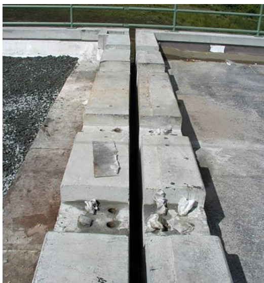
a) b) Obr. 2.39 – Železniční estakáda Parník v Dlouhé Třebové – ukončení nosné konstrukce příčnými přepážkami: a) přepážky před zašterkováním mostu a zřízením koleje, b) po zřízením koleje; most v km 250,241 na TÚ 1501 Česká Třebová – Praha
