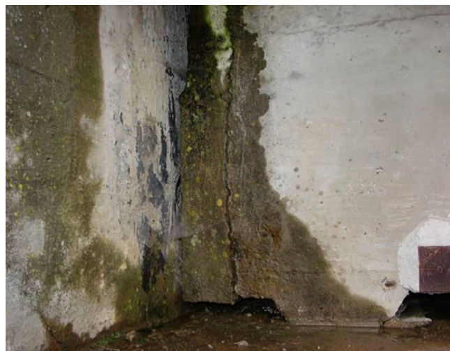
Obr. 4.41 – Železniční most ve Veselí nad Lužnicí – obetonování kotev předpínací výztuže vyplňující celou mezeru mezi čelem nosné konstrukce a závěrnou zídou; most v km 35,605 na TÚ 1781 Nemanice – Veselí nad Lužnicí
