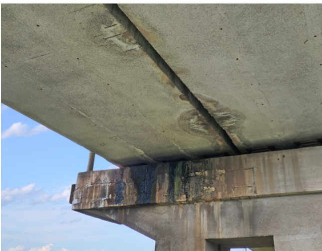
Obr. 3.99 – Typické poruchy nosníků „I“ – zatékání na NK
