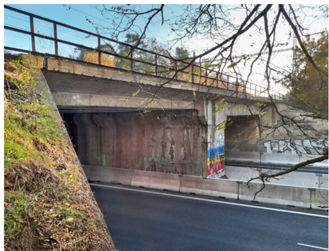
Obr. 3.14 – Železniční most přes dálnici D10 ve Staré Boleslavi: a) pohled od Mladé Boleslavi – původní předpjatá konstrukce je ve středním poli, z této strany je však viditelné pozdější rozšíření mostu; b) pohled od Prahy – detail (původní předpjatá je bližší konstrukce); most v km 348,054 na TÚ 0921 Lysá nad Labem – Všetaty
