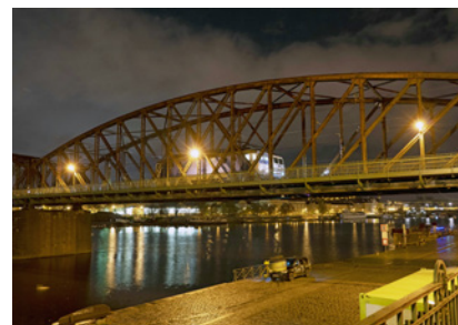
Rekonstrukce železničních mostů pod Vyšehradem – statická a dynamická ověřovací zatěžovací zkouška mostu, dlouhodobé sledování mostu 1,3,4 Investor: SŽ, s.o.
