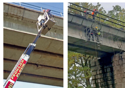
Diagnostika a statické posouzení železničních mostů s nosnou konstrukcí z předpjatého betonu 1,2,3
