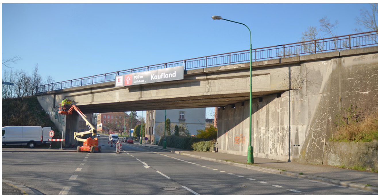
Obr. 3.103 – Železniční most přes silnici I/33 ul. Husova v Jaroměři – pohled; most v km 41,301 na TÚ 1601 Hradec Králové hl.n – Stará Paka
