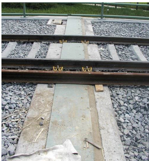
a) b) Obr. 2.39 – Železniční estakáda Parník v Dlouhé Třebové – ukončení nosné konstrukce příčnými přepážkami: a) přepážky před zašterkováním mostu a zřízením koleje, b) po zřízením koleje; most v km 250,241 na TÚ 1501 Česká Třebová – Praha
