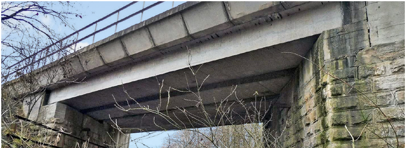
Obr. 3.70 – Železniční most přes řeku Stupavu v Bohuslavicích u Kyjova – pohled; most v km 59,006 na TÚ 2302 Brno-Černovice – Vlárský průsmyk
