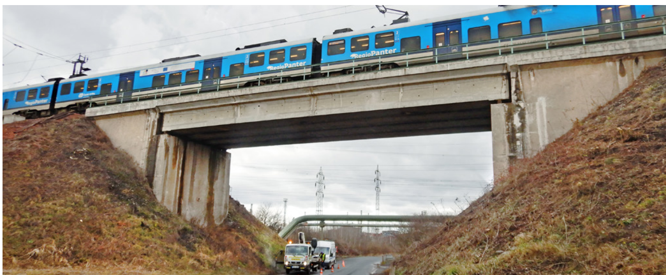
Obr. 3.108 – Železniční most přes ulici Ledvická u Chotějovic – pohled; most v km 31,446 na TÚ 0591 Ústí nad Labem – Most
