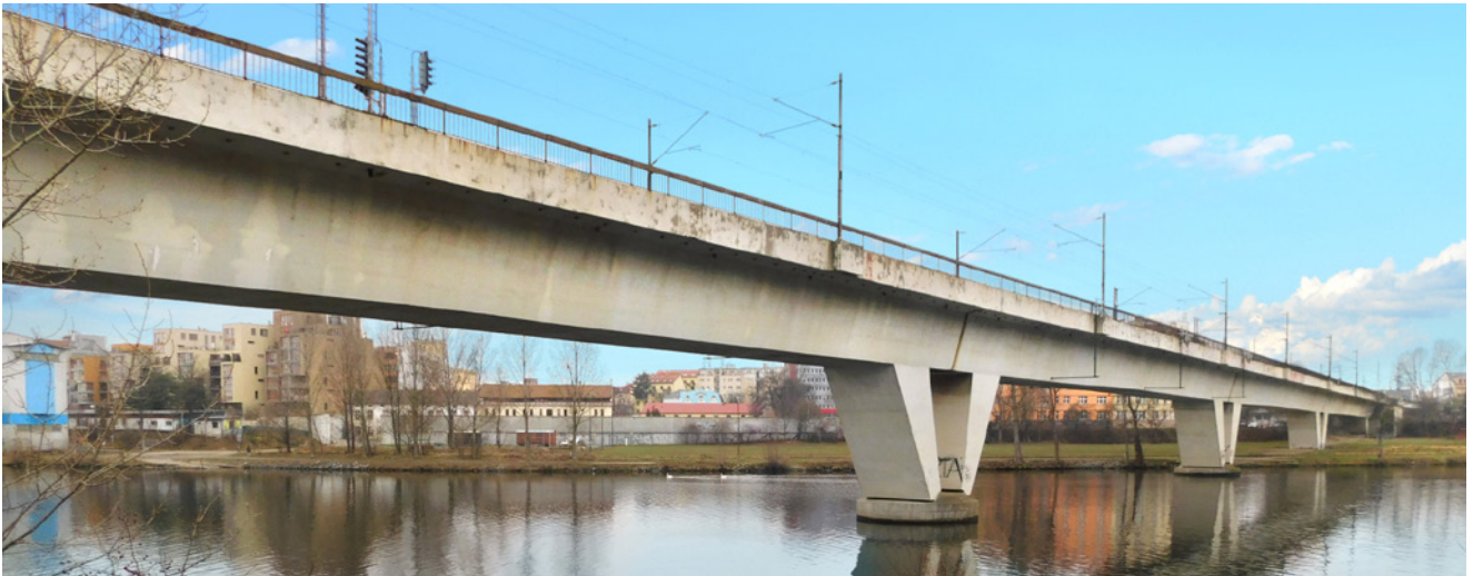
Obr. 3.115 – Železniční most přes Vltavu v Praze – pohled; most v km 3,346 na TÚ 0791 Praha-Libeň – Praha-Holešovice
