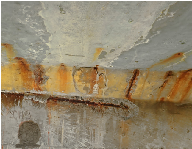
Obr. 3.90 – Typické poruchy nosníků T-66 - vlevo: koroze měkké výztuže v náběhu mezi stojinou a horní přírubou nosníku; vpravo: obnažená betonářská výztuž konzoly; most v km 12,805 na TÚ 0661 Velvěty–Kozlíky
