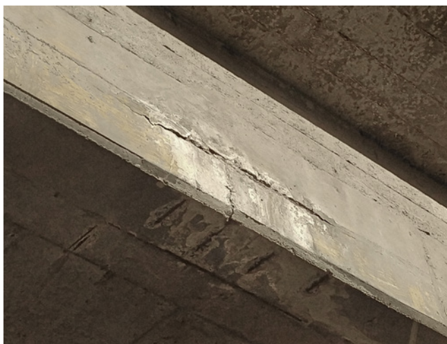
Obr. 3.135 – Vlevo: nejvýznamnější poruchou nosné konstrukce jsou podélné trhliny se stopami po průsacích, které kopírují trajektorii předpínací výztuže; vpravo: průsaky dilatačními spárami u vložených polí – dochází k hloubkové degradaci betonu, korozi výztuže, zatékání na kotevní oblasti předpínací výztuže
