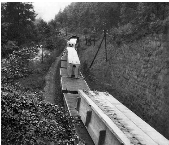
Obr. 3.4 – Přeprava trámů
