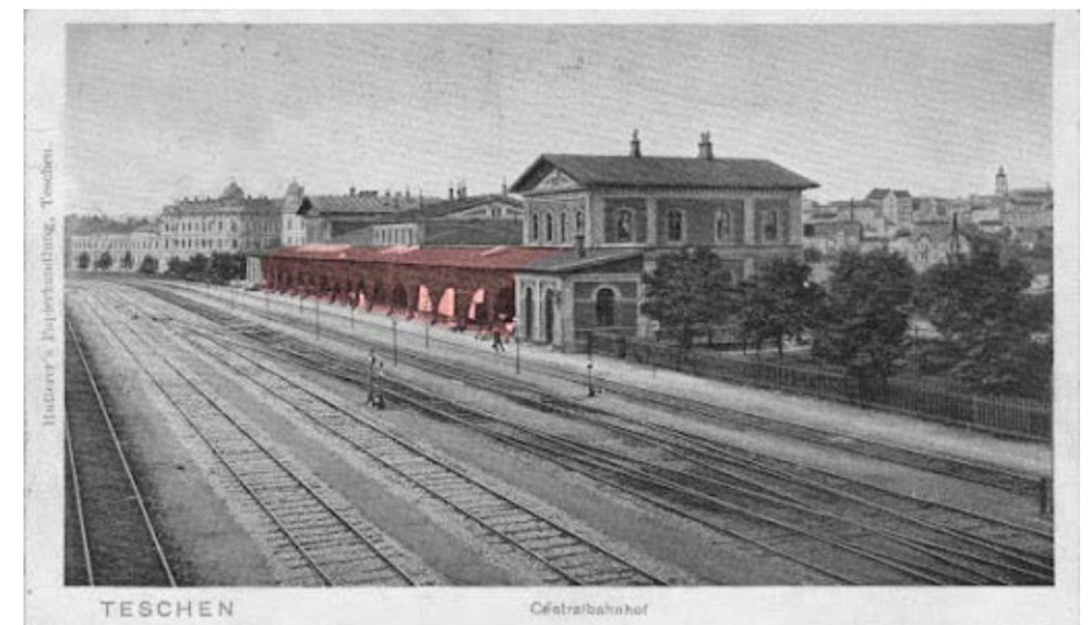
Historická typologie kryté exteriérové čekárny
