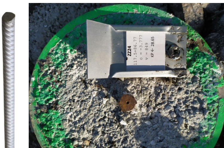
Obr. C.6 - Roxor v betonovém bloku (ZZ)
