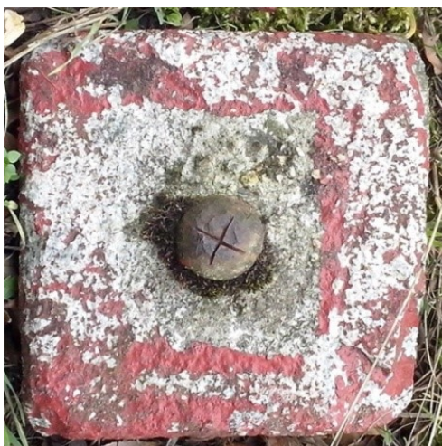
Obr. C.9 - Kámen M2 s nivelačním znakem
