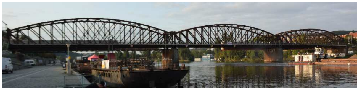
Obr. 1: Pohled na železniční most pod Vyšehradem
