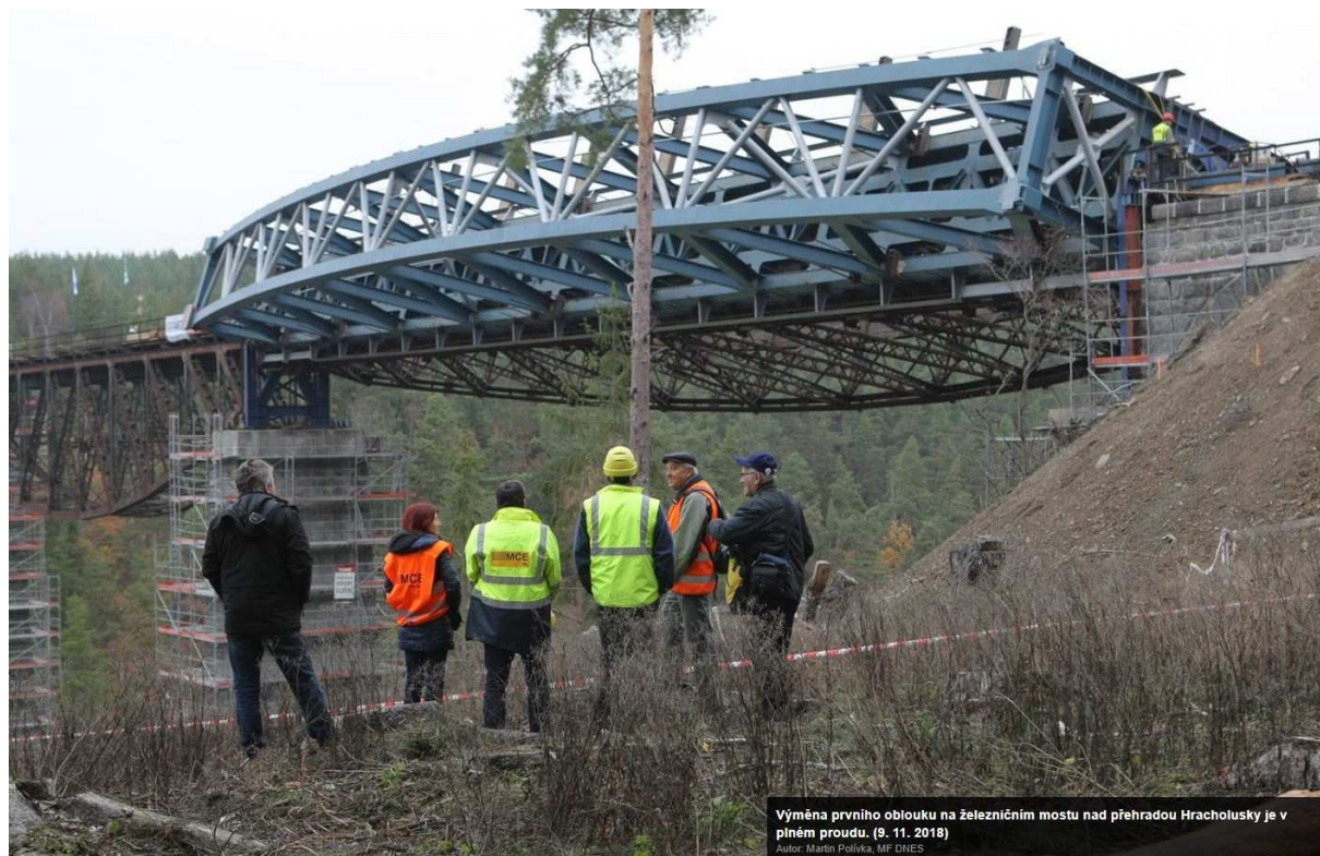
Obr. 13: Výměna prvního oblouku
