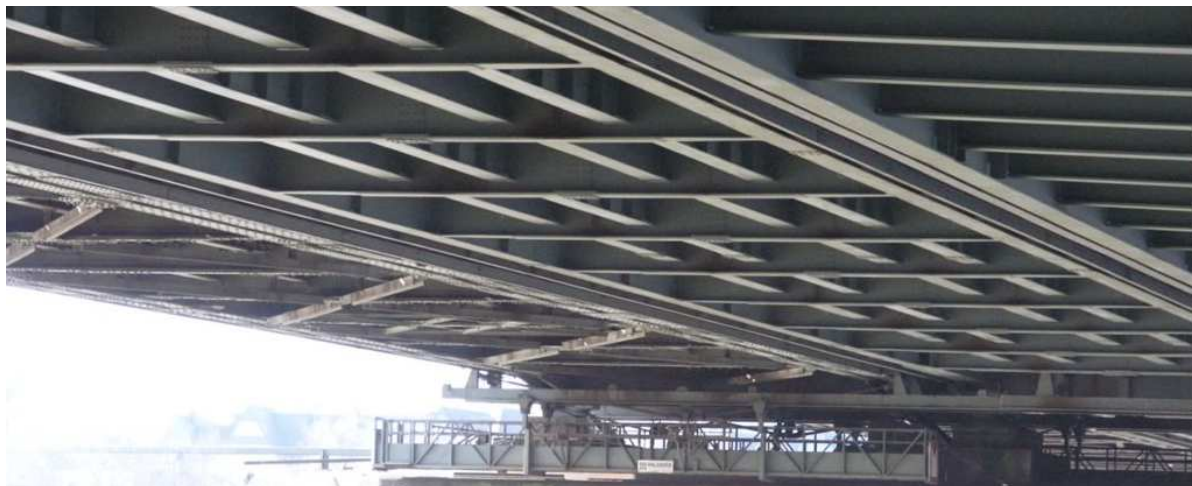
Obr. 18: Různá konstrukční řešení mostovky každého ze tří dvojkolejných mostů
