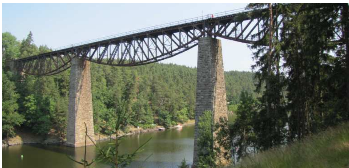
Obr. 12: Pohled na most před rekonstrukcí
