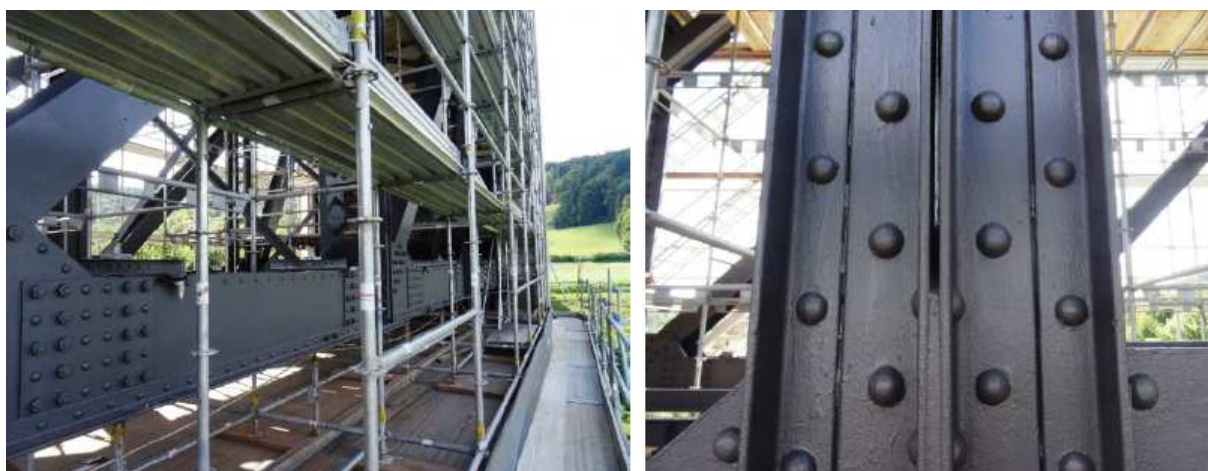
Obr. 25: Pohled na konstrukci po aplikaci nové PKO, vpravo je ukázáno, že lze vyčistit a aplikovat PKO i do úzkého prostoru mezi plechy bez nutnosti vyplnění spáry
