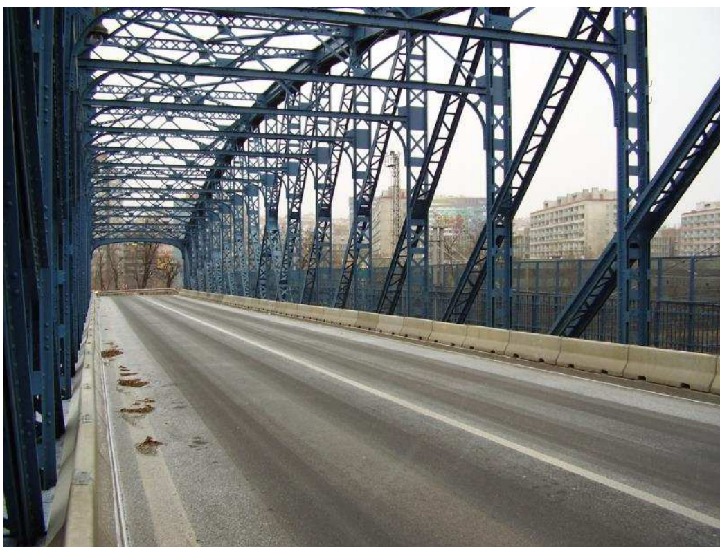
Obr. 4: Částečný pohled na konstrukci mostu
