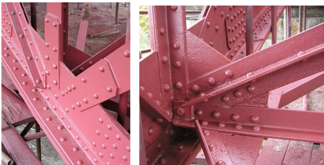
Obr. 9: Detaily mostní konstrukce po opravě
