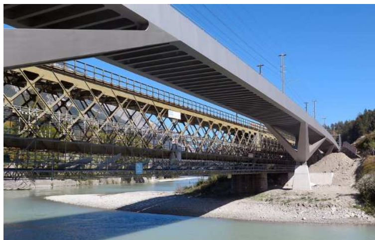
Obr. 31: Obrázky představující příklad realizovaného jednokolejného ocelového mostu Zweite Hinterrheinbrücke ve Švýcarsku poblíž Churu (Nosná konstrukce ze 2 ocelových nosníků výšky 1,7 m vytažených 0,5 m nad niveletu koleje, žlab pro kolejové lože, šikmé vzpěry, rozpětí polí cca 46,5 - 40,1 – 63,0 - 45,9 m)
