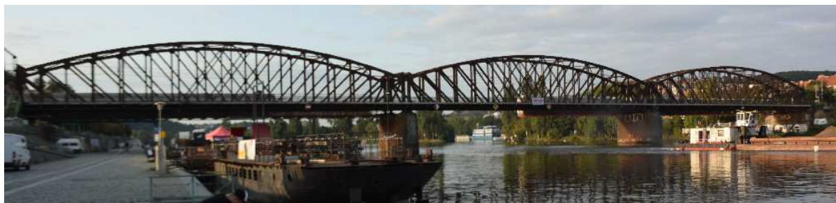
Obr. 1: Pohled na železniční most pod Vyšehradem
