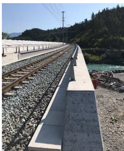
Obr. 31: Obrázky představující příklad realizovaného jednokolejného ocelového mostu Zweite Hinterrheinbrücke ve Švýcarsku poblíž Churu (Nosná konstrukce ze 2 ocelových nosníků výšky 1,7 m vytažených 0,5 m nad niveletu koleje, žlab pro kolejové lože, šikmé vzpěry, rozpětí polí cca 46,5 - 40,1 – 63,0 - 45,9 m)
