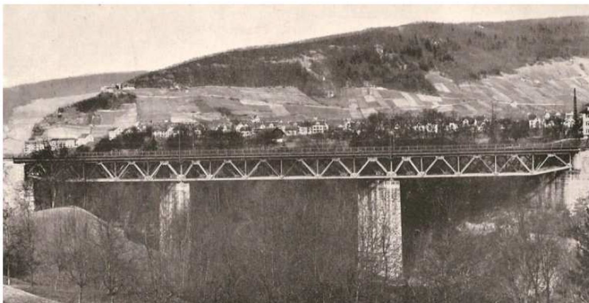
Obr. 21: Pohled na most
