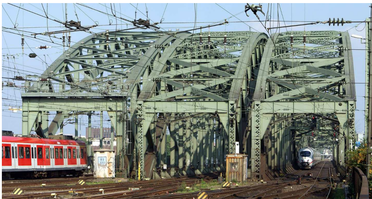
Obr. 17: Různá konstrukční řešení každého ze tří dvojkolejných mostů patrná z rozdílnosti krajních portálových rámu
