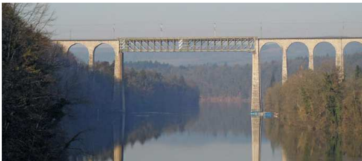
Obr. 22: Pohled na most Most přes Rýn v Eglisau
