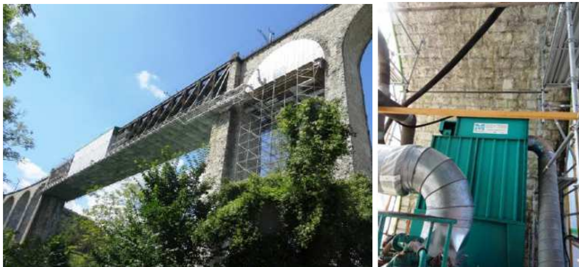
Obr. 23: Vzduchově nepropustné zaplachtování, vpravo pohled dovnitř zaplachtování
