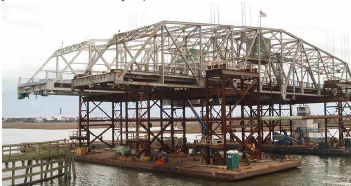
Obr. 26: Výměna hlavního příhradového pole – horizontální přesun přes montážní bárky.
